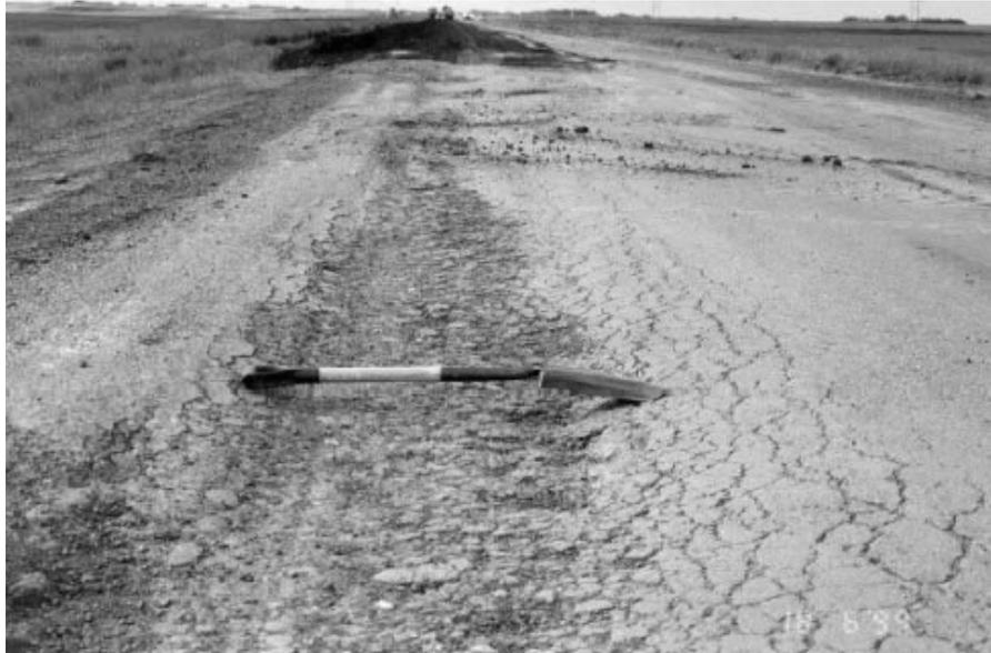
**Figura 3.3 d - Deformação permanente por trilha de roda**
