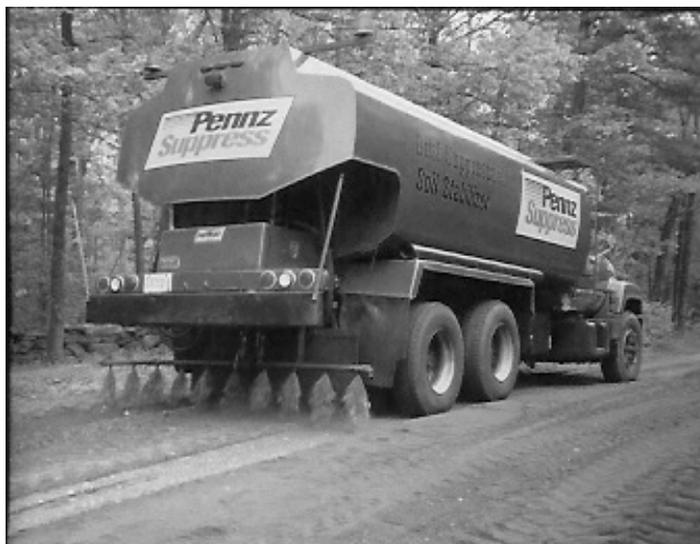
**Figura 5.9 – Aplicação de agente estabilizante químico em solução aquosa.
