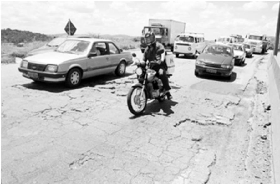
**Figura 3.3 c - Defeitos do tipo trincas, buraco, desagregações**
