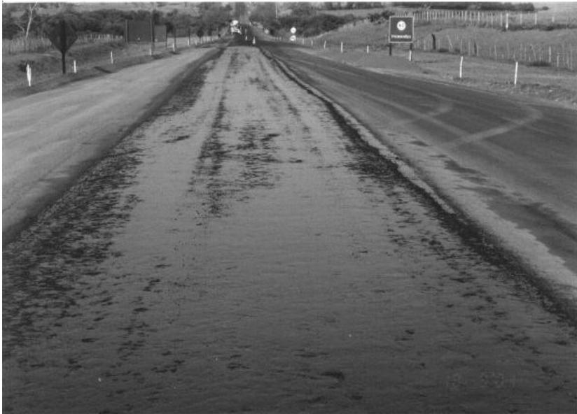
**Figura 6.22 – Vista da superfície imprimada.**
