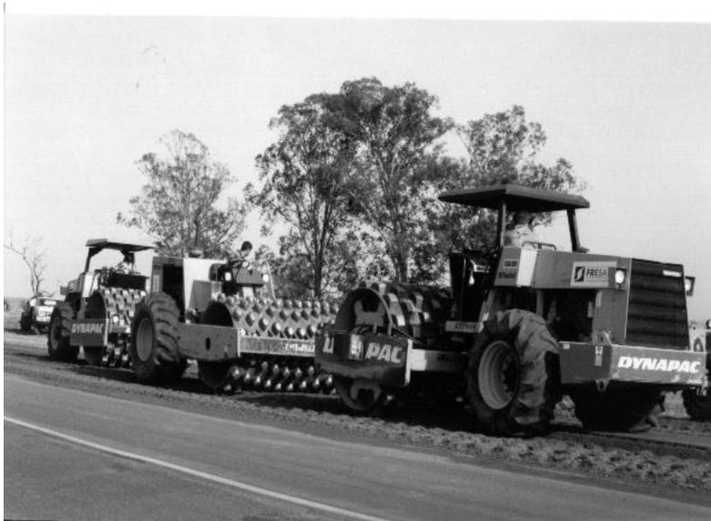
**Figura 6.19 – Compactação do material reciclado.**
