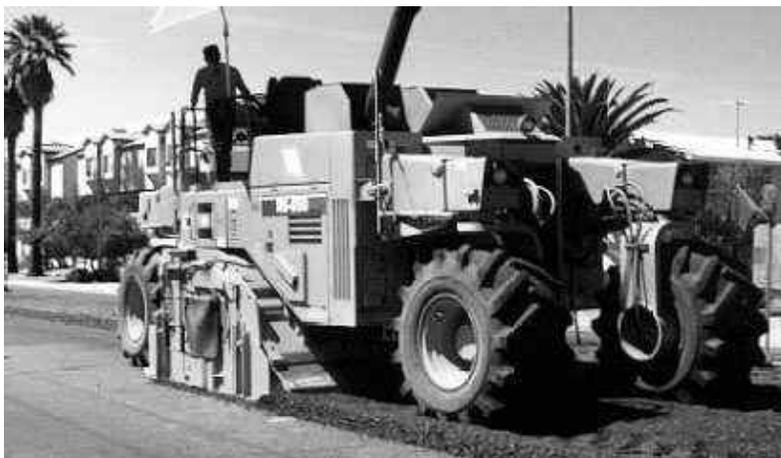
**Figura 6.16 – Recicladora triturando o pavimento existente**
