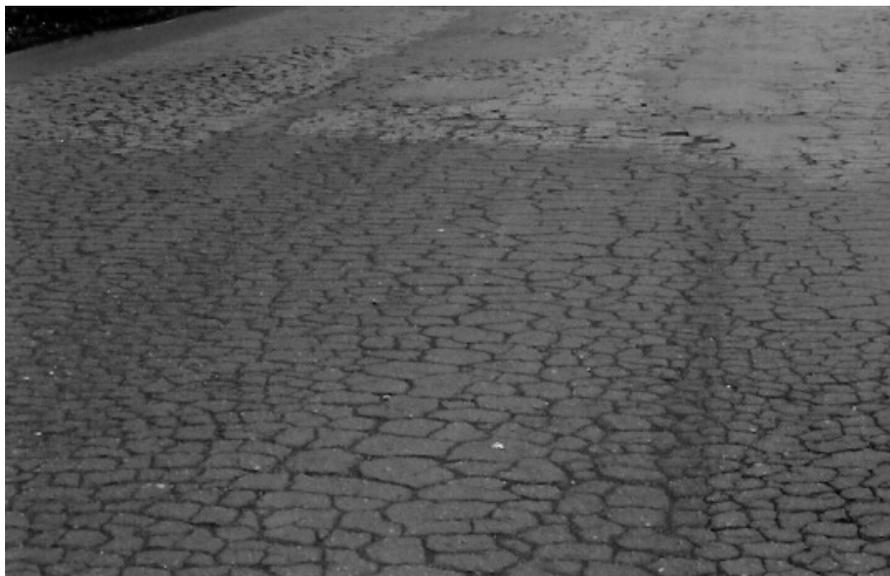
**Figura 33 a – Trincas por fadiga**
