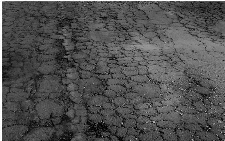
**Figura 6.31 – Capa asfáltica excessivamente trincada.**
