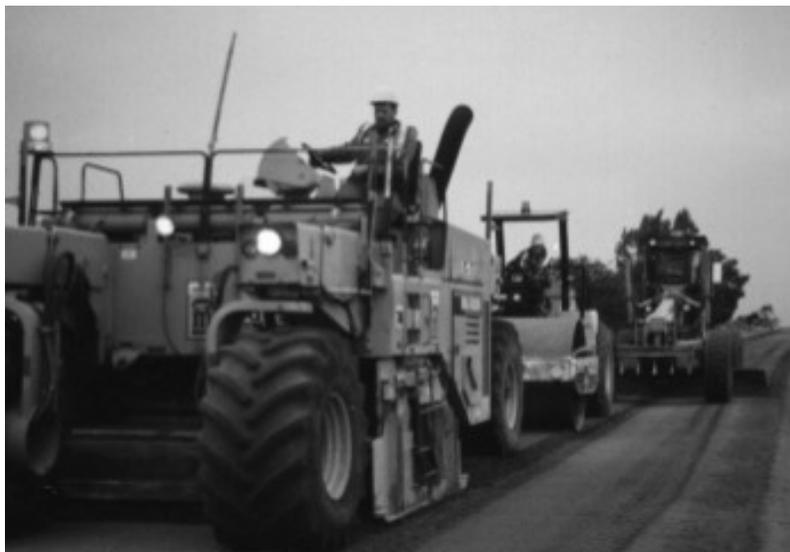
**Figura 6.18 – Pré-compactação seguida do perfilamento geométrico.**
