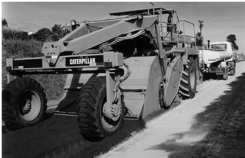
**Figura 5.6 - Reciclagem profunda com incorporação de cimento.**
