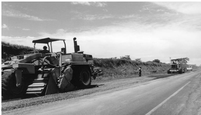
**Figura 5.3 – Reciclagem profunda com incorporação de agregados novos**
