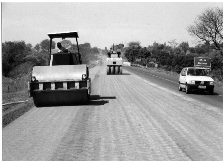
**Figura 6.20 – Acabamento na superfície da camada reciclada**
