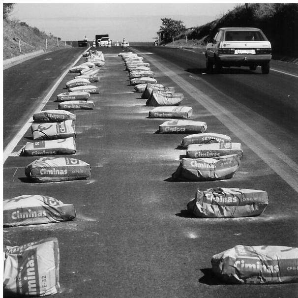
**Figura 5.4 – Lançamento de cimento em sacos na pista.**
