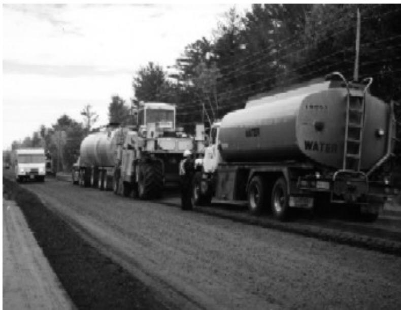
**Figura 6.17 – Estabilização da mistura com aplicação de agente estabilizante**
