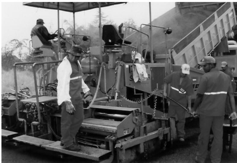
**Figura 6.24 – Aplicação do revestimento asfáltico sobre a camada reciclada**
