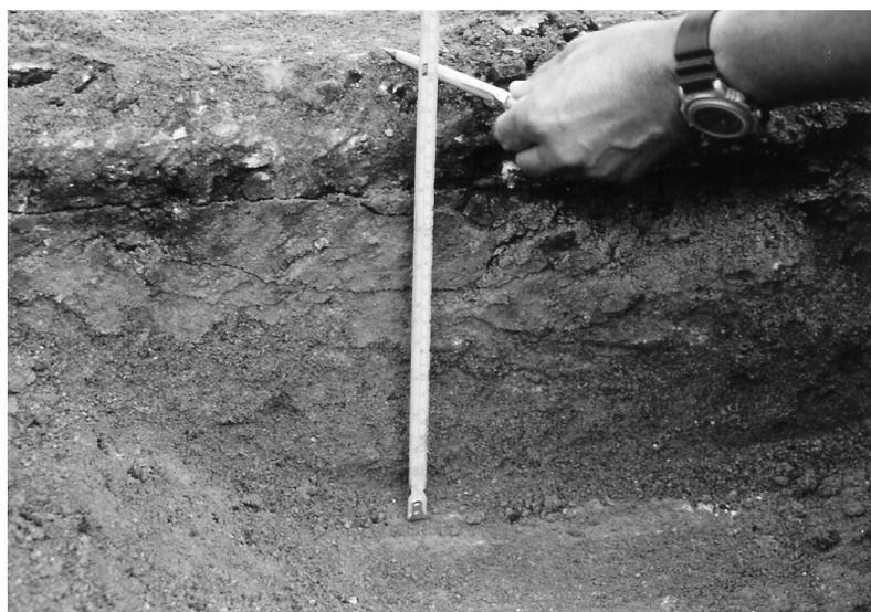
**Figura 6.28 – Controle da espessura de corte**
