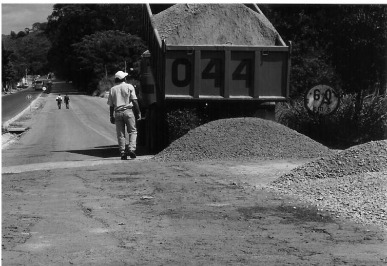
**Figura 5.1 – Lançamento de agregado novo na pista**
