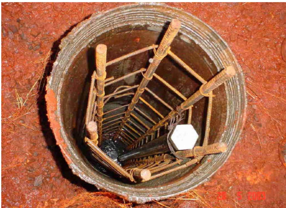
**Figura 3.40** – Armadura e tubo colocados (anterior à injeção de argamassa) .
