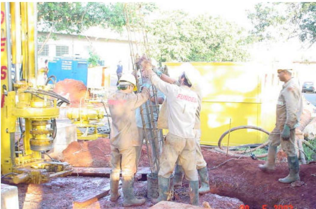
**Figura 3.39** – Descida da armadura dentro do tubo de revestimento após perfuração.
