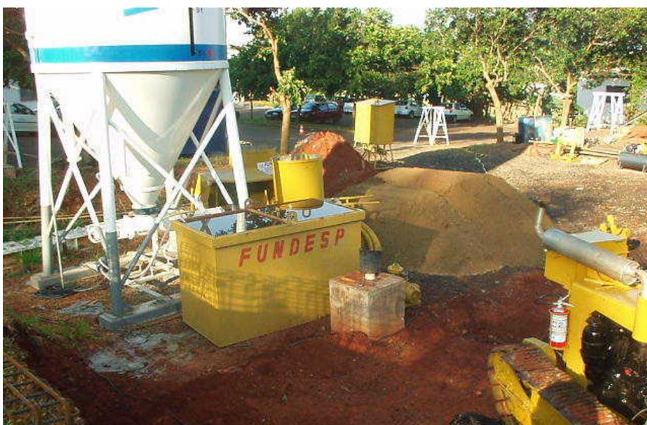
**Figura 3.30** – Reservatório de água para a dosagem da argamassa.
