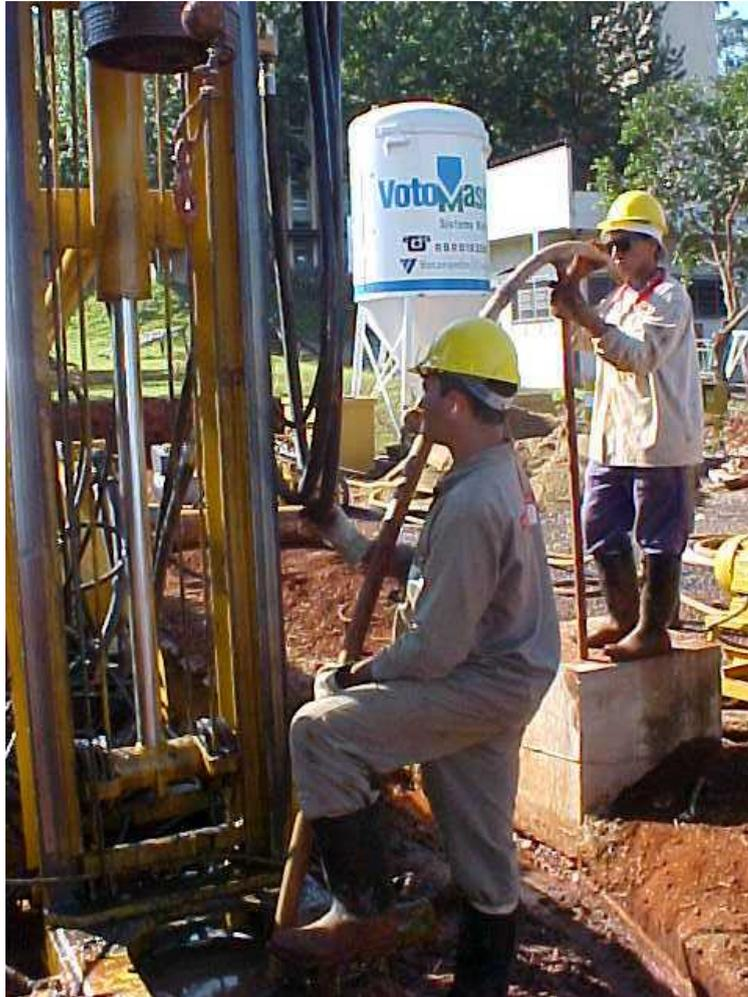
**Figura 3.41** – Processo de injeção de argamassa .
