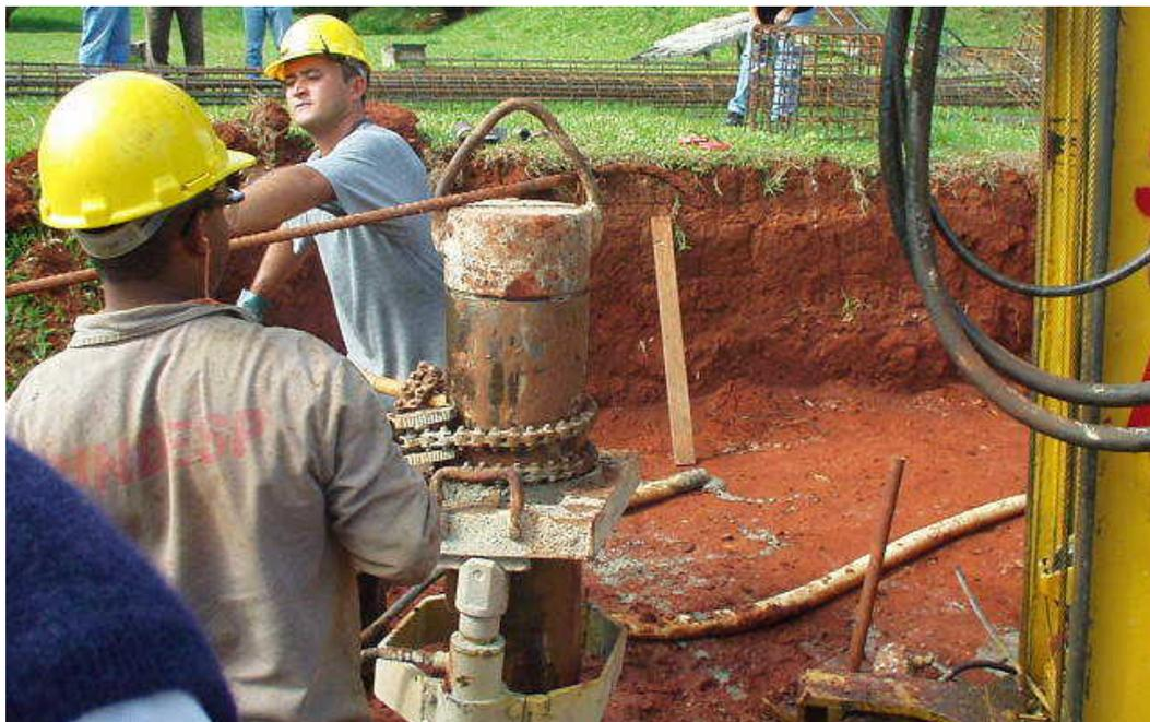
**Figura 3.48** – Colocação da cabeça do revestimento .
