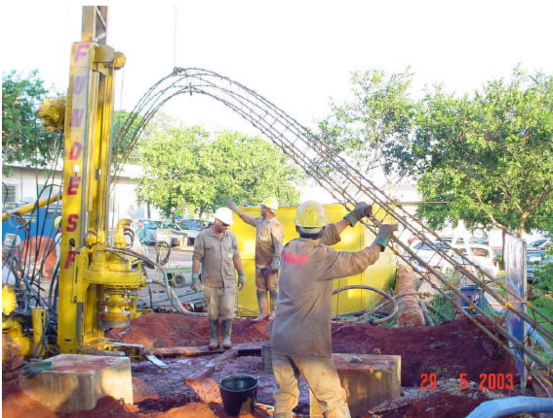
**Figura 3.6** – Colocação da armadura dentro do tubo de revestimento.
