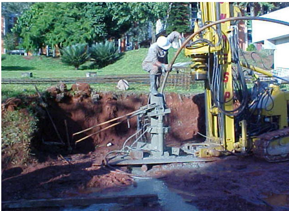
**Figura 3.44** – Extravasamento da argamassa (término da expulsão da água).
