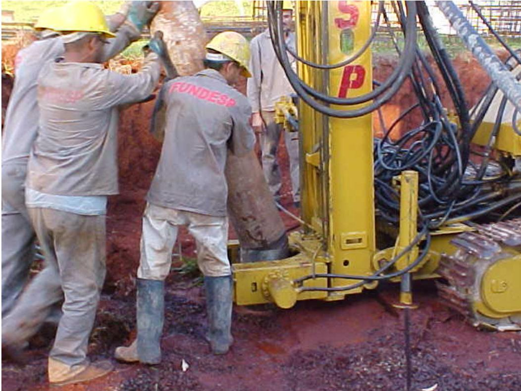
**Figura 3.38** – Rosqueamento de novo tubo de revestimento (de quatro a seis tubos foram utilizados).
