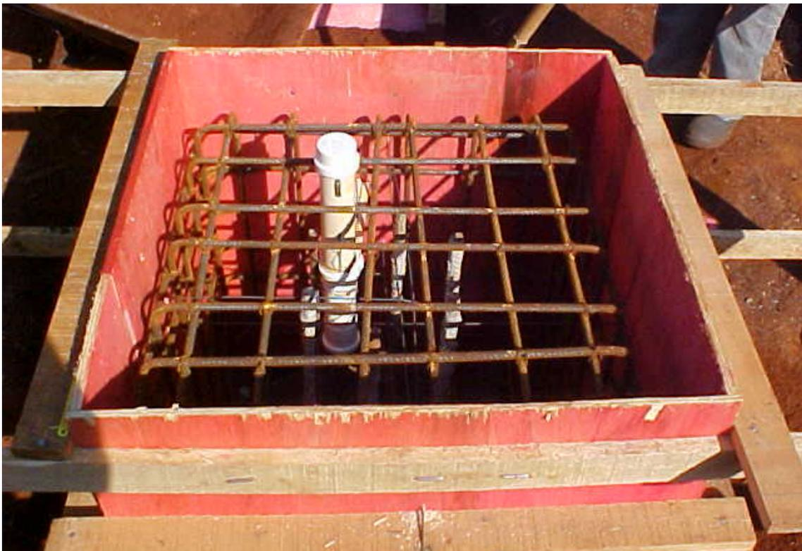
**Figura 3.10** – Armadura, barras de espera e tubo de PVC posicionados na forma de concretagem.
