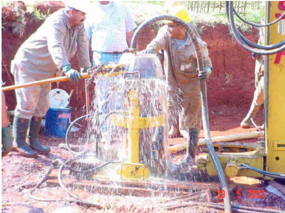
**Figura 3.43** – Injeção da argamassa e verificação da saída da água .
