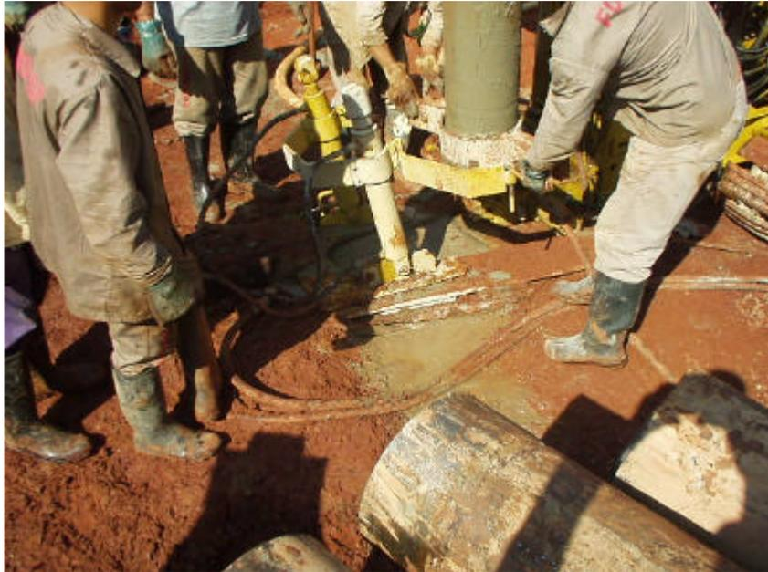
**Figura 3.47** - Término da retirada do tubo .
