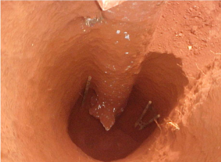
**Figura 6.1** - Escavação de tubulão circundando a estaca e aparecimento de protuberância no fuste.
