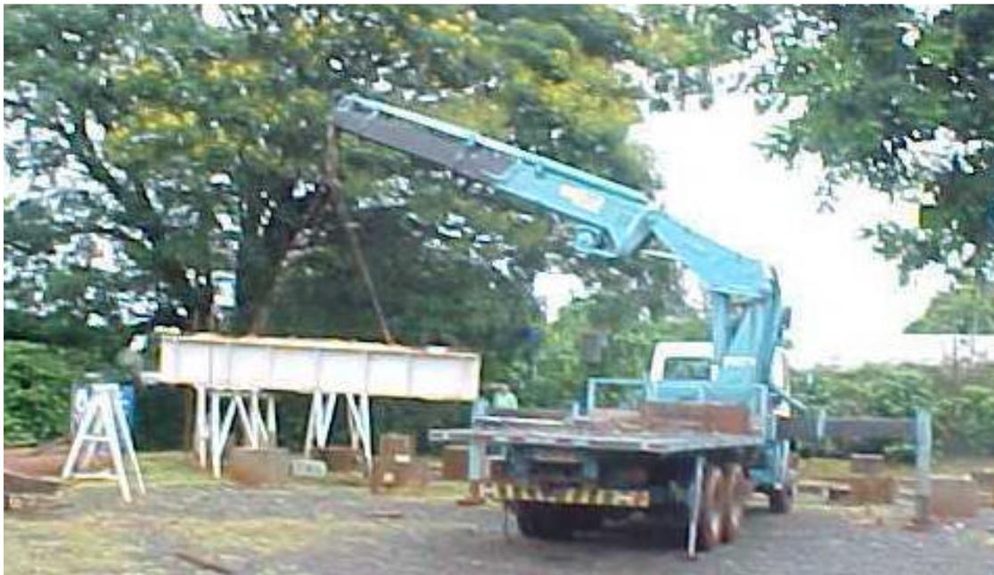
Figura 3.12 – Içamento da Viga de Reação com o auxílio de Munck.
