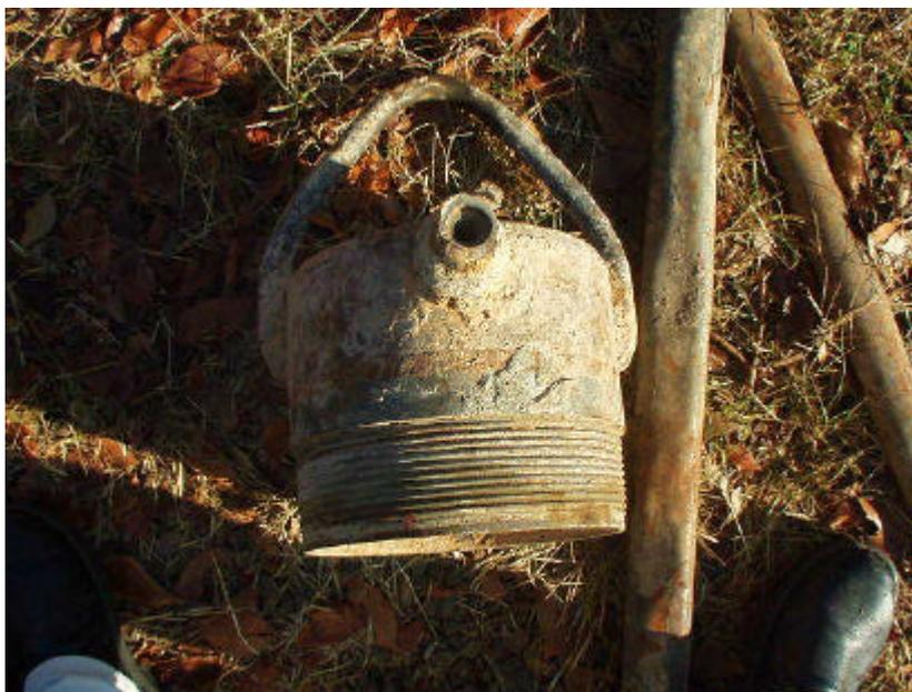
**Figura 3.35** – Cabeça do revestimento (dotada de entrada de ar na parte superior).
