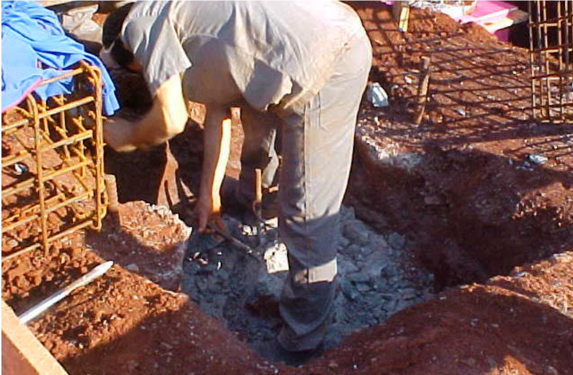
**Figura 3.9** – Arrasamento da cabeça da estaca teste.
