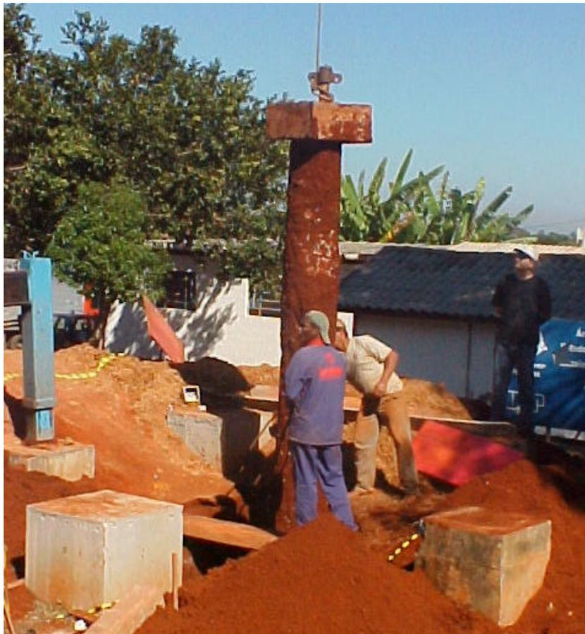
**Figura 6.2** – Içamento da estaca com auxílio de Munck.
