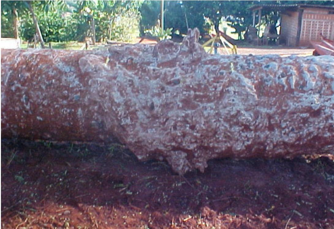
**Figura 6.8** – Detalhe do fuste entre 1,50m e 2,0m de profundidade.
