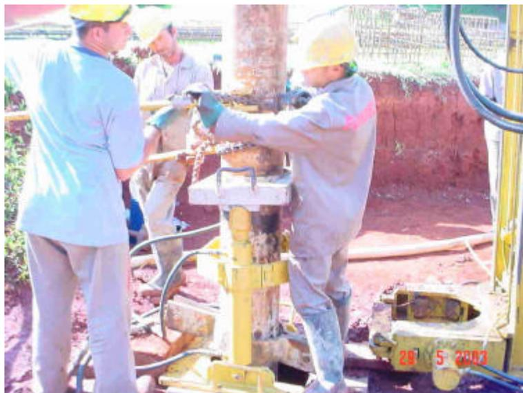
**Figura 3.45** - Colocação do conjunto extrator e chaves de corrente tipo jacaré .
