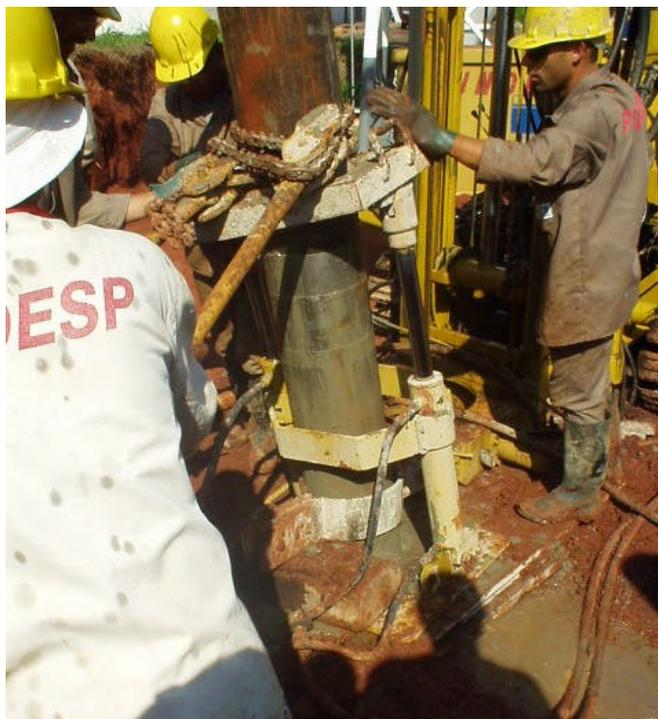
**Figura 3.46** - Retirada do tubo por ação coaxial ao eixo da estaca .
