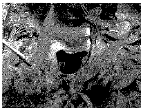
Inspeção rompida terreno.
