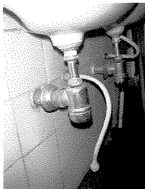
Figura 5.66: Flexível desencaixado - EMEI 159.
