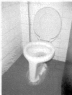
Bacia cimentada - CEMEI/EMEI 151
