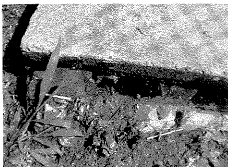
Figura 5.22: Caixa de inspeção de esgoto sanitário transbordando e disposição de esgoto na sarjeta.
