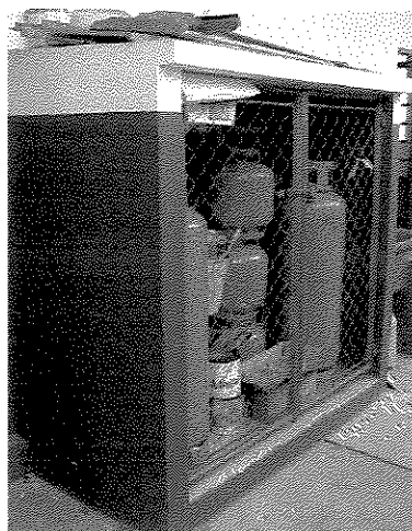
Figura 5.43: Central de gás utilizada como depósito de materiais – EMEI 133
