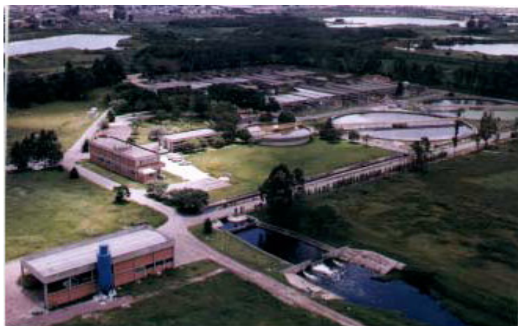
Figura E.3 - Foto panorâmica de Estação de Tratamento de Esgoto – sistema aeróbico (extraído de material da empresa SANEPAR) – adaptado MTE 2003
