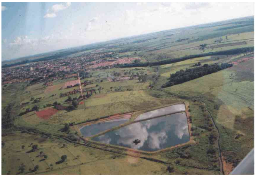
Figura E.1 - Foto: Sistema de tratamento de esgoto por lagoas de estabilização na cidade de Promissão, São Paulo -adaptado DAEE 2003
