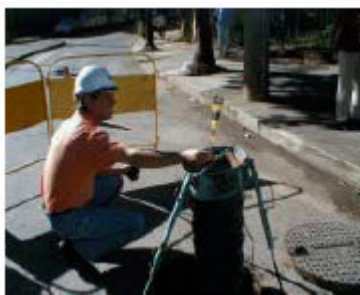
Figura C.3 - Uso simultâneo de insuflador de ar e a fase aspiração de ar insuflado – adaptado MTE 2003
