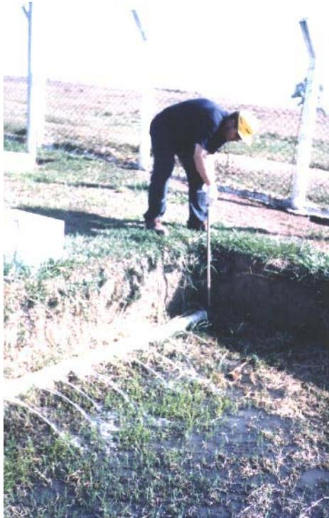
**Figura 3.6 – Desobstrução dos orifícios da tubulação nos pontos de aplicação do efluente**
