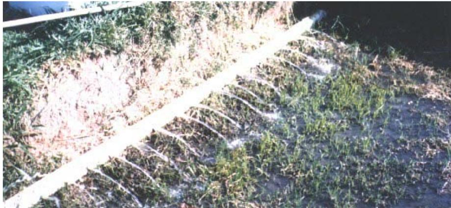
**Figura 3.5 – Aplicação do efluente na cabeceira das rampas.**
