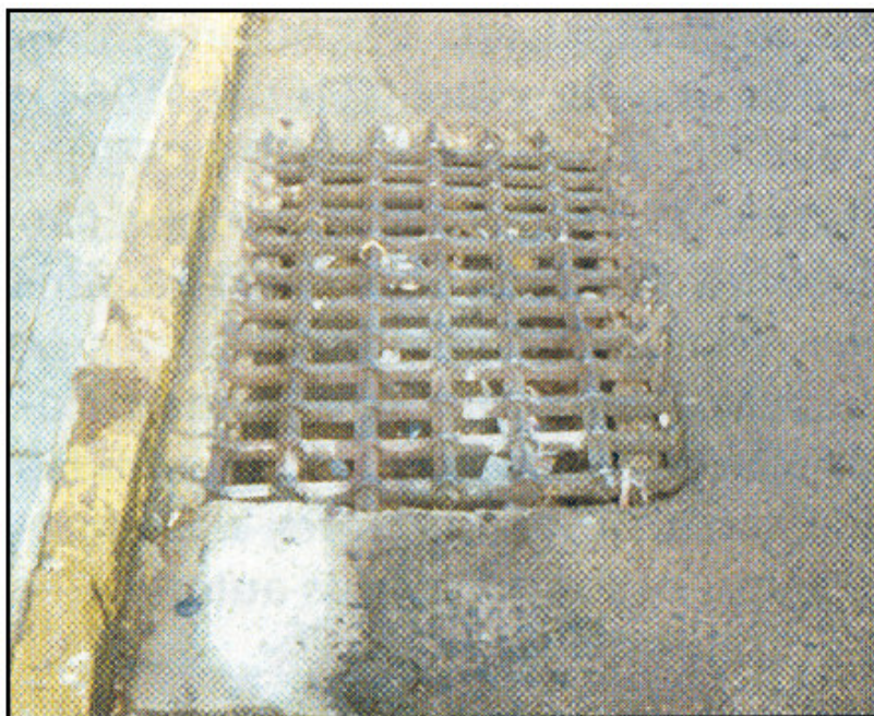
Figura 5.3. Boca-de-lobo com grelha quadriculada fixa.
