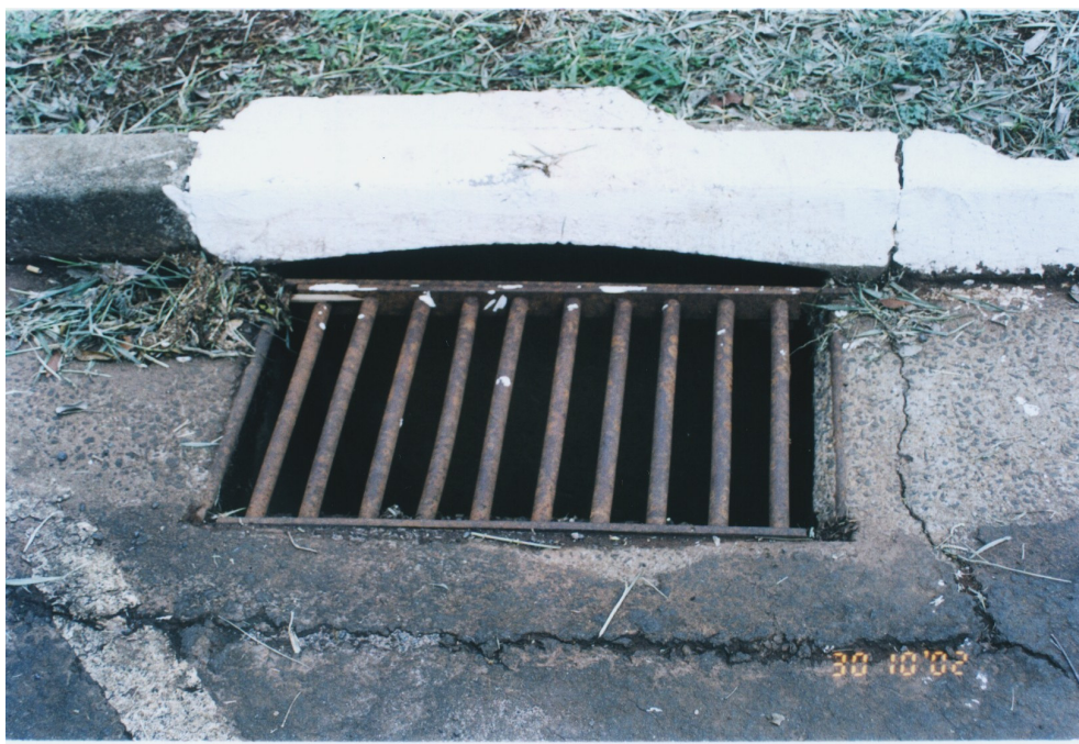
Figura 5.11. Boca-de-lobo simples, com abertura na guia e grade.
