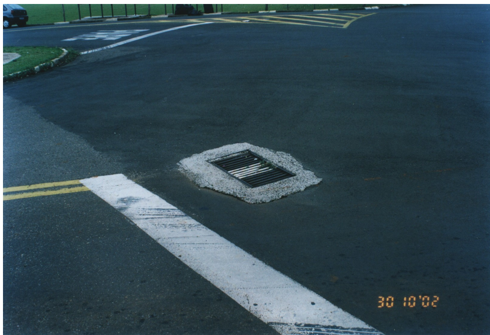
Figura 5.13. Boca-de-lobo simples e com grade. Estrutura localizada no campus da UNICAMP/Campinas/SP.
