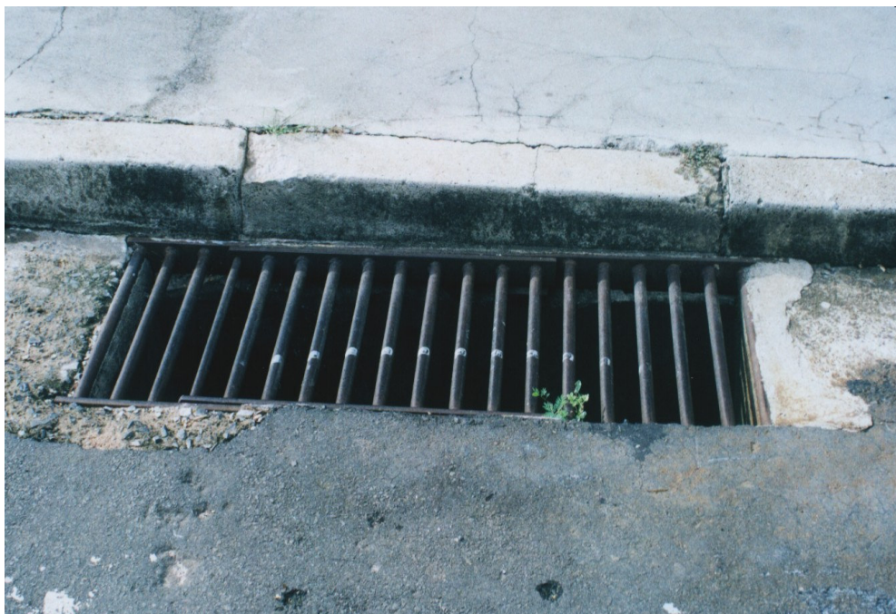
Figura 5.22. Boca-de-lobo simples com grade. Estrutura localizada na cidade de Limeira/SP.
