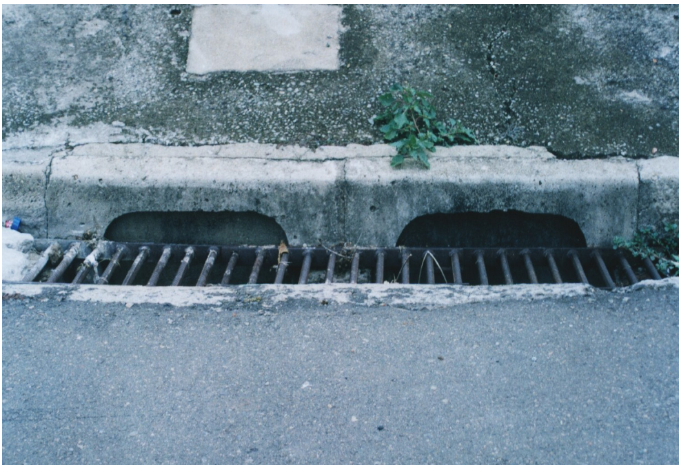
Figura 5.19. Boca-de-lobo múltipla com abertura na guia e com grade. Estrutura localizada na cidade de Limeira/SP.
