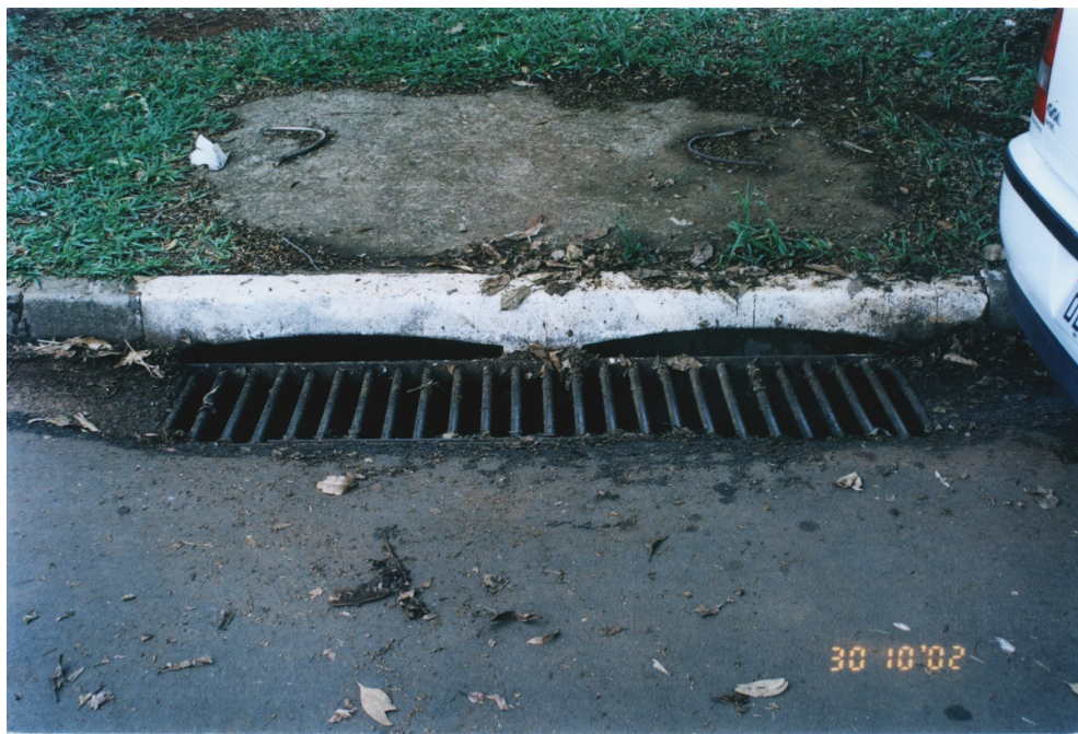
Figura 5.12. Boca-de-lobo múltipla com abertura na guia e grade. Estrutura localizada no campus da UNICAMP/Campinas/SP.
