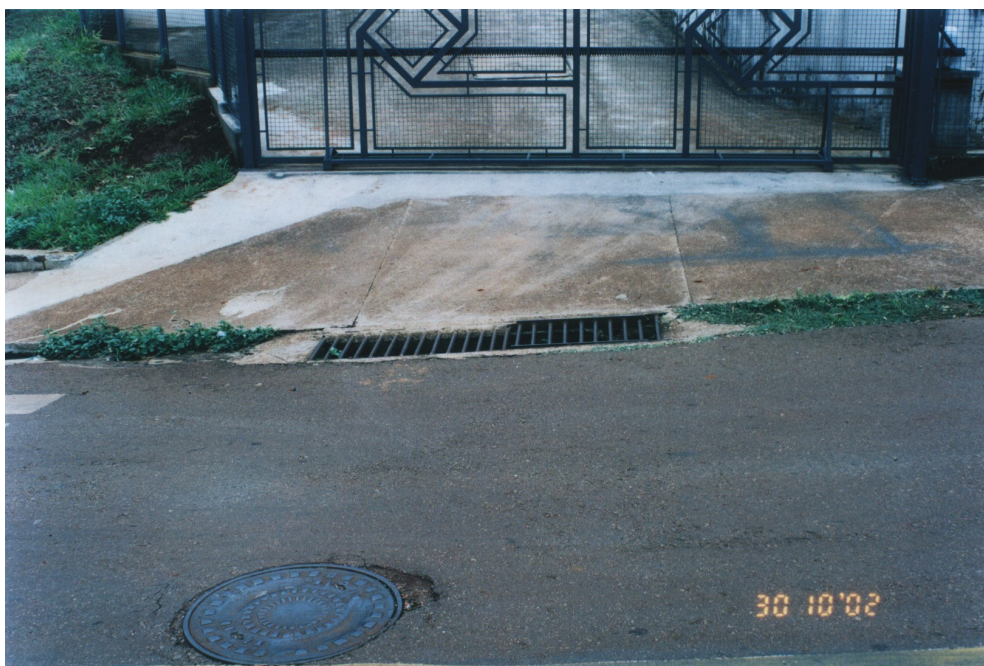
Figura 5.14. Boca-de-lobo múltipla e com grade.
