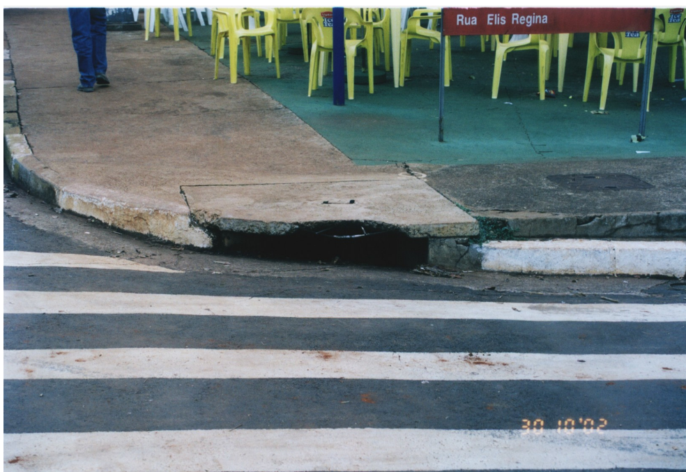
Figura 5.15. Boca-de-lobo simples e com abertura na guia.
