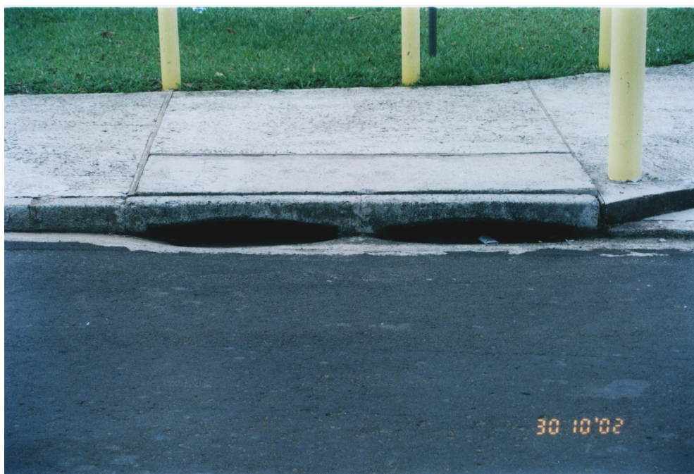
Figura 5.16. Boca-de-lobo múltipla e com abertura na guia com depressão. Estrutura localizada na cidade de Campinas/SP.
