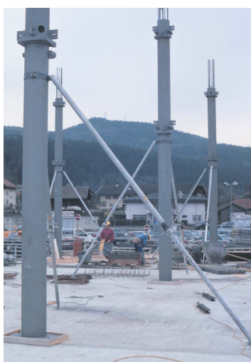
Figura 2.12 – Contraventamentos provisórios utilizados na montagem de pilares mistos.
