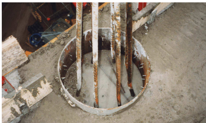
Figura 2.7 – Pilar tubular circular preenchido com concreto.
