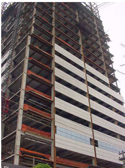
Figura 2.5 – Pilares parcialmente revestidos com concreto.
