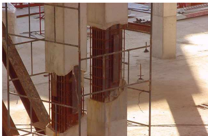
Figura 2.4 – Pilares totalmente revestidos com concreto.
