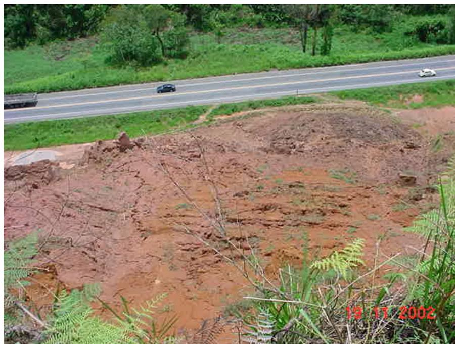
Foto 5.5 – Vista do escorregamento de montante para jusante. Notar o ligeiro desvio da massa rompida para a direita em relação à rodovia.
