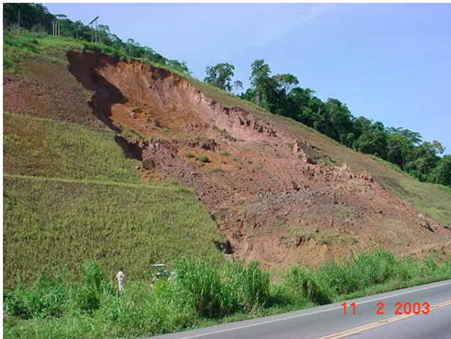
Foto 5.2 - Talude – BR 116 – km 368 – Vista lateral da ruptura geral ocorrida em 14/08/2001
