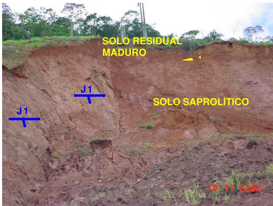
Foto 5.3 – Detalhe da crista da ruptura – Notar perfil de alteração e a família de juntas (J1).
