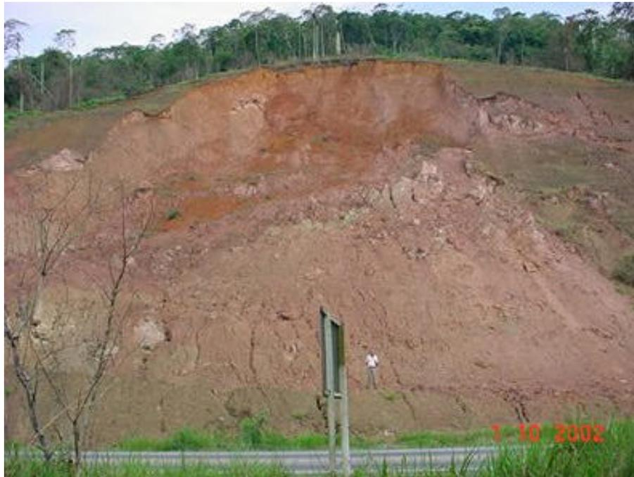
Foto 5.1 - Talude – BR 116 – km 368 – Vista frontal da ruptura geral ocorrida em 14/08/2001
