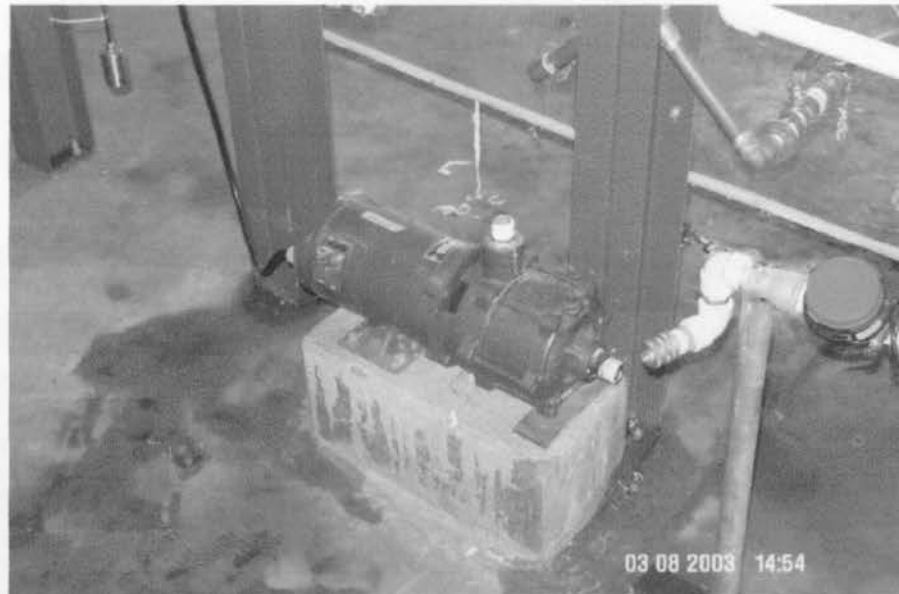
Figura 4.18 – Bomba de rotação variável.
