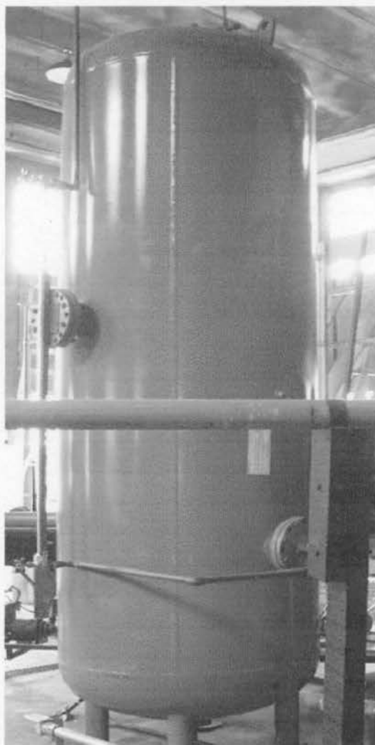
Figura 4.8 - Reservatório hidropneumático.
