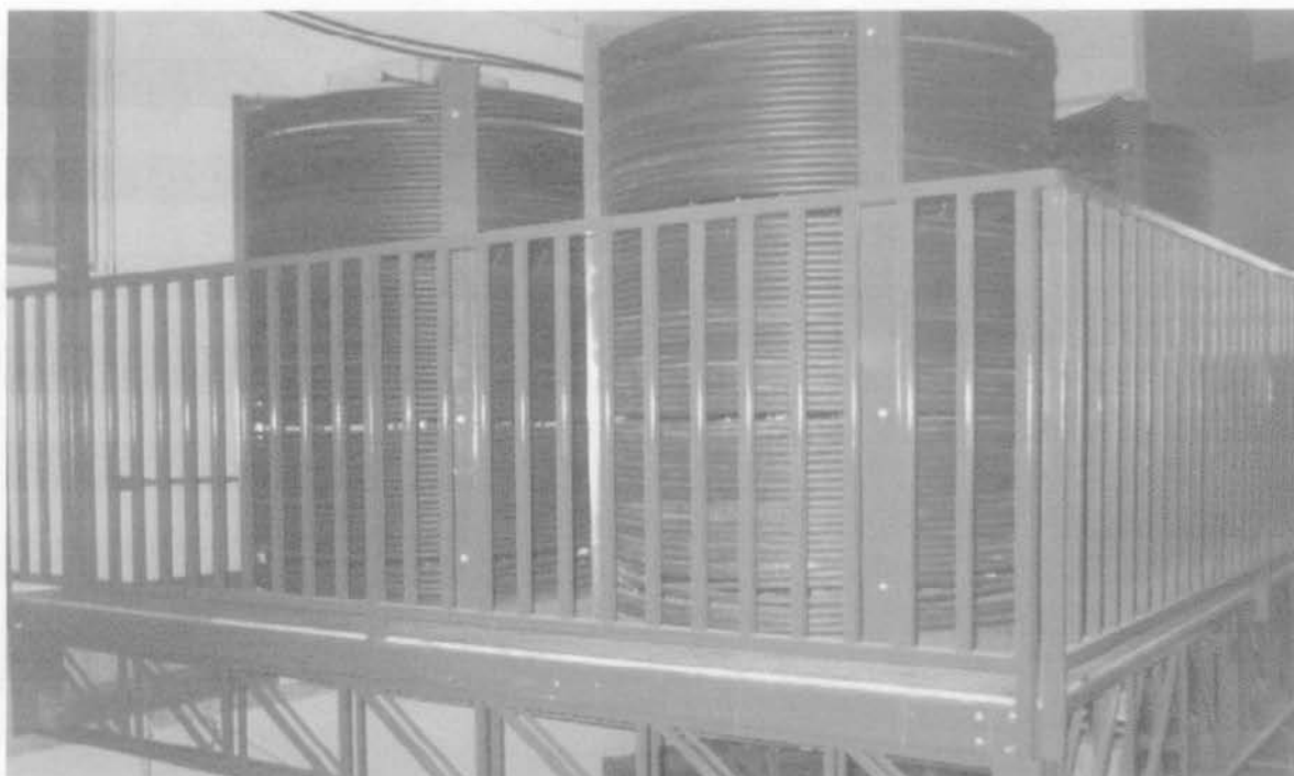
Figura 4.10 – Tubulação de PEAD em formato em hélice.
