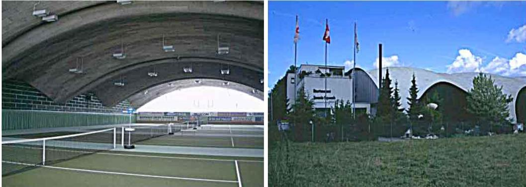
Figura 5.16 – Acabamentos Interno e Externo de Casca Construída por Isler
