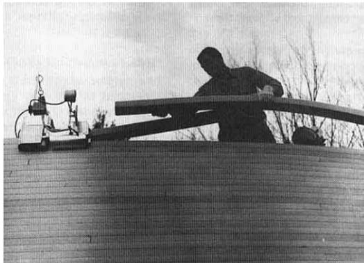
Figura 5.42 – Construção de Casca com *Styrofoam®*
