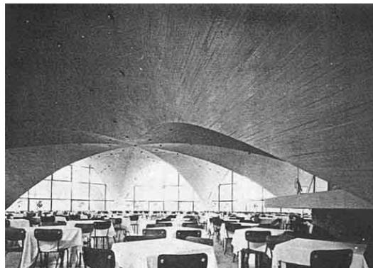
Figura 5.17 – Acabamento Interno de uma Casca Construída por Candela
