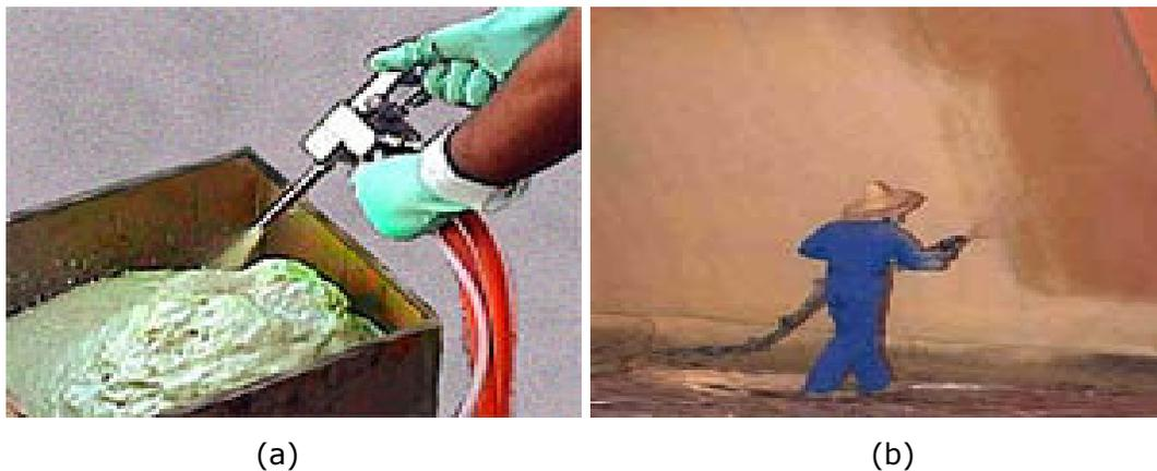
Figura 5.24 – Aplicação da Espuma
