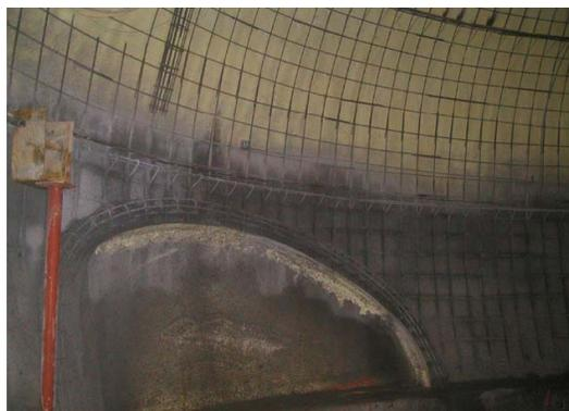
Figura 5.28 – Concretagem da Casca
