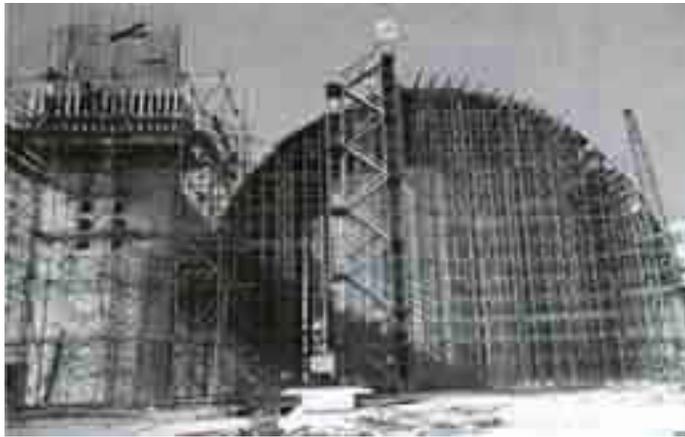
Figura 5.11 – Detalhe de Escoramento de uma Estrutura em Casca
