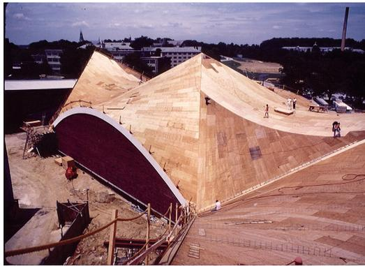
Figura 5.8 – Montagem da Fôrma
