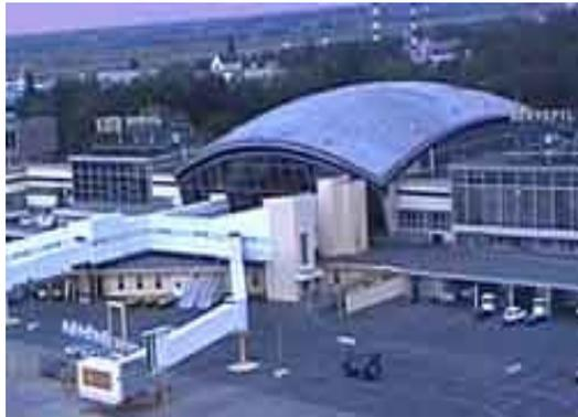
Figura 5.40 – Vista Externa de um Casca Pré-Moldada (Aeroporto de Kiev)
