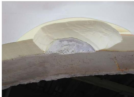
Figura 5.30 – Detalhes das Camadas da Estrutura em Casca
