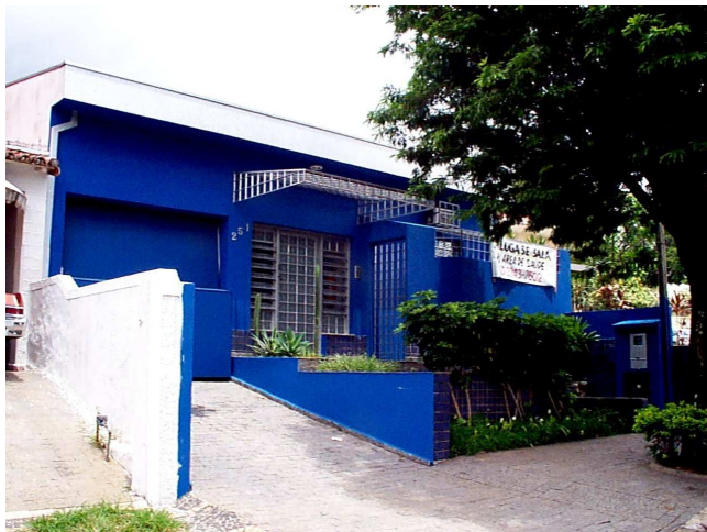
Vista parcial da fachada do consultório C09
