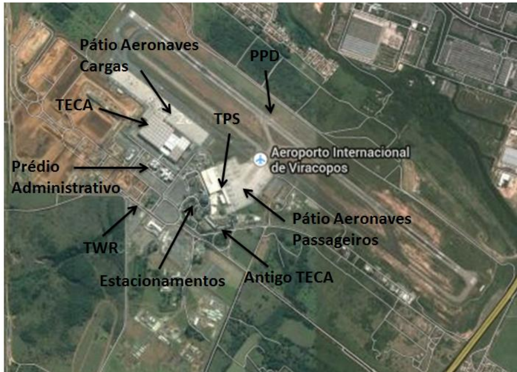
Figura 14: Foto aérea do aeroporto com indicação das principais infraestruturas existentes
