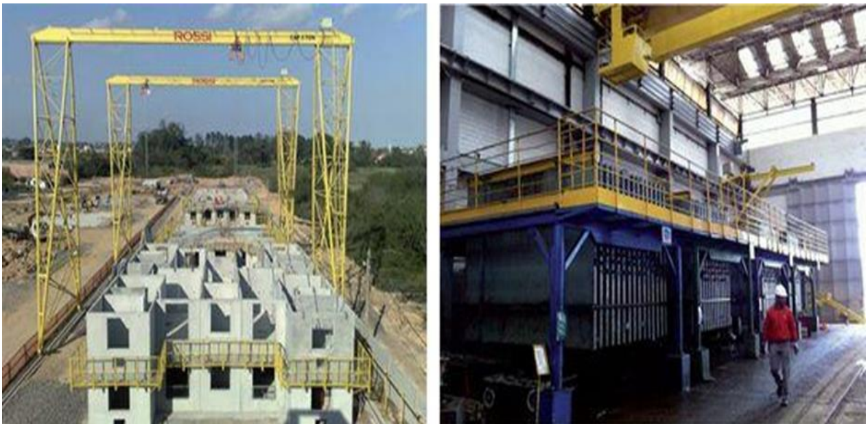
FIGURAS 16 E 17: MONTAGEM DE PAINÉIS EM OBRA; FABRICAÇÃO INDUSTRIALIZADA DE PAINÉIS. FONTE: HPF ENGENHARIA
