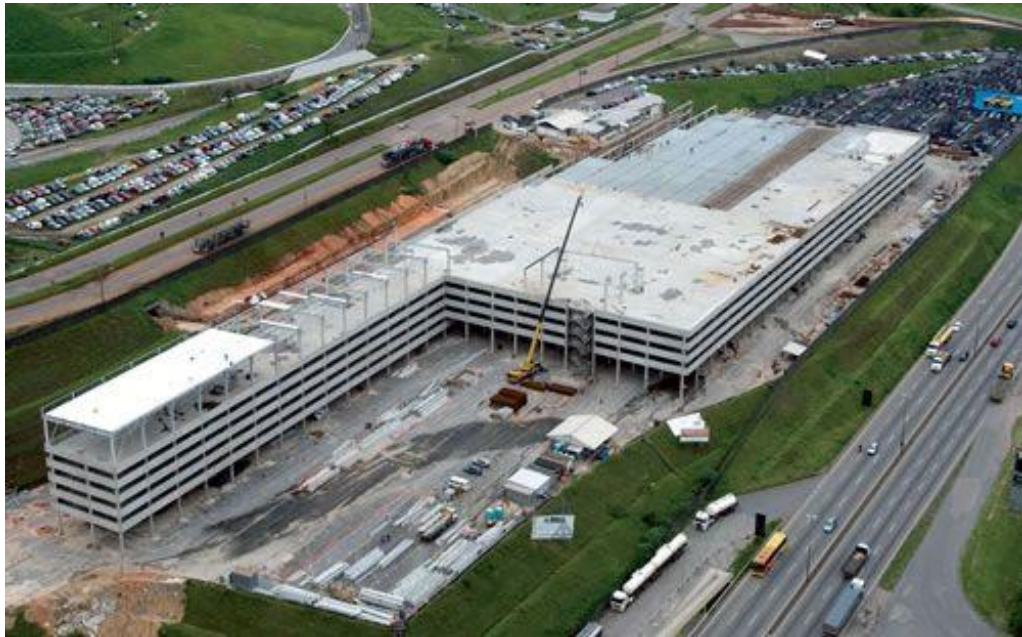
FIGURA 12: ESTACIONAMENTO VERTICAL DE VEÍCULOS EM BETIM (MG) FONTE: BRASIL ENGENHARIA (2014)
