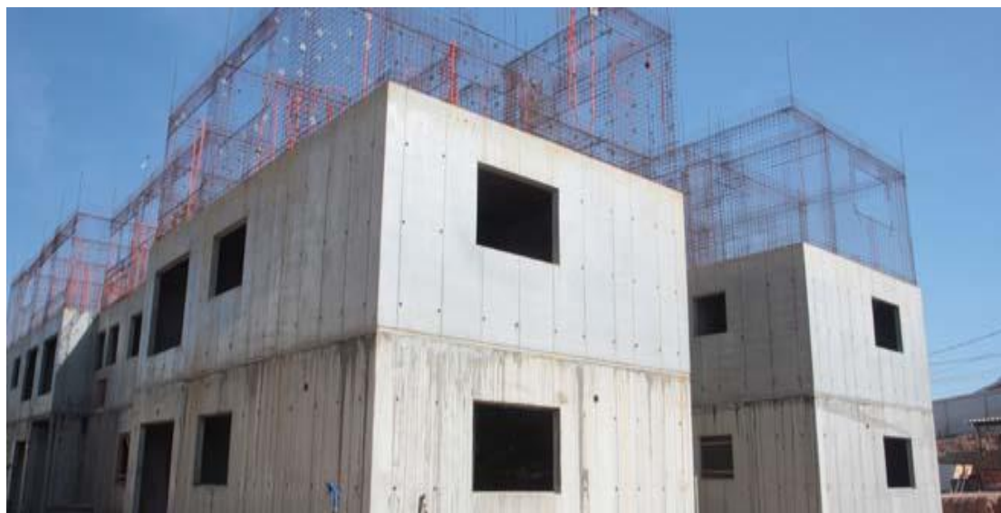
FIGURA 15: CONSTRUÇÃO DE EDIFÍCIO COM PAREDES EM CONCRETO FONTE: ABESC (2013)
