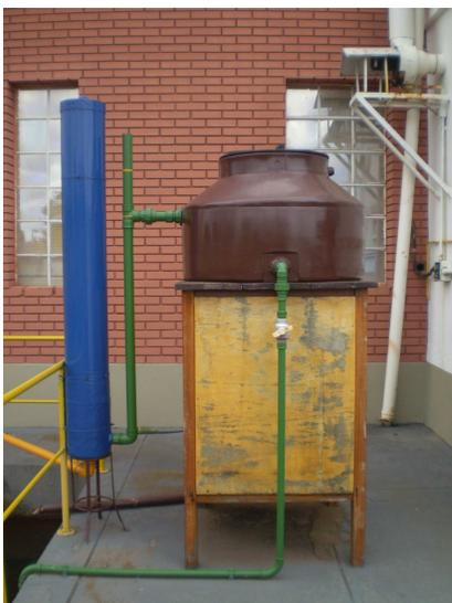
O sistema tem capacidade para 44 kg de pastilhas, que em função da área do sistema resulta em uma densidade aparente de 0,8 kg/L.
