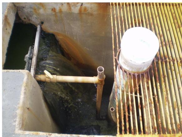
A instalação do clorador no final da ETE, além de ser o local adequado para desinfecção do efluente, também tem a vantagem de apresentar menor variação de vazão, uma vez que a mesma foi equalizada na passagem pelas três lagoas dispostas antes do clorador.
