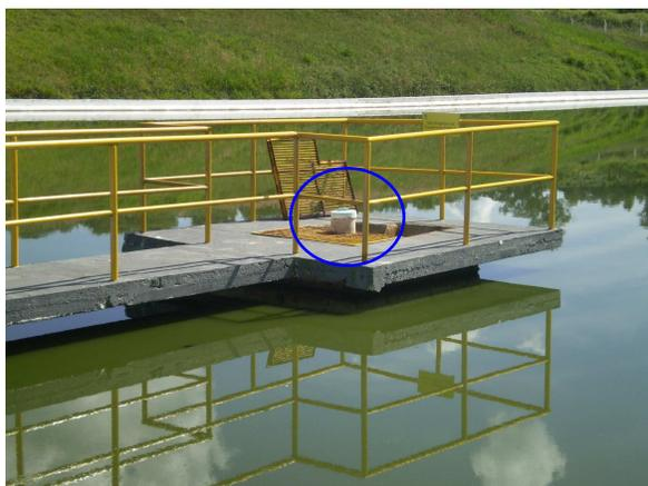
Figura 4.15 Fluxo de esgoto no clorador
