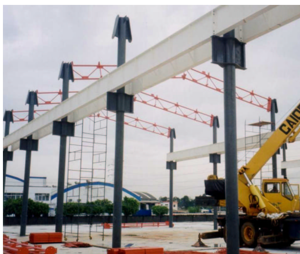
Figura 1.3 - Galpão realizado pela AçoTubo - Brasil.
