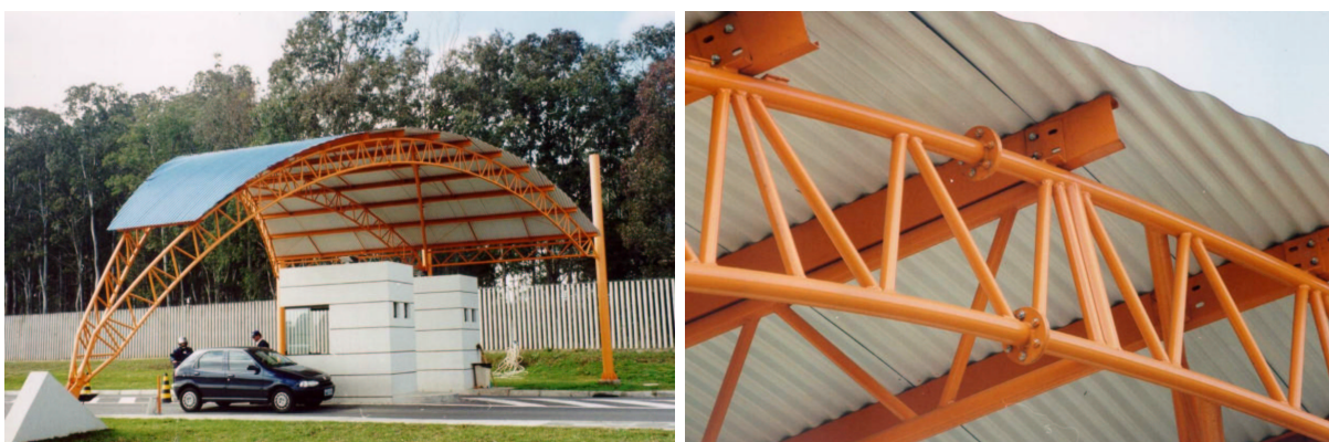
Figura 1.4 - Guarita na entrada de acesso em Curitiba - Brasil.
