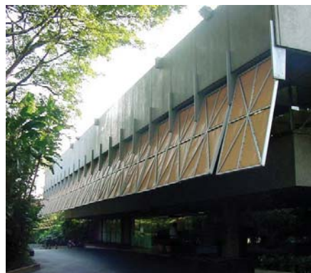
Figura 14 - Sede do Clube Harmonia, São Paulo, 1964. Arquitetos: Fábio Pentead, Alfredo Paesani e Teru Tamaki Fonte: www.arquiteturabrutalista.com.br
