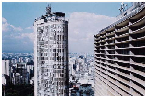
Figura 10 - Edifício Itália, São Paulo. Arquiteto: Franz Heep Fonte: www.placesonline.es
