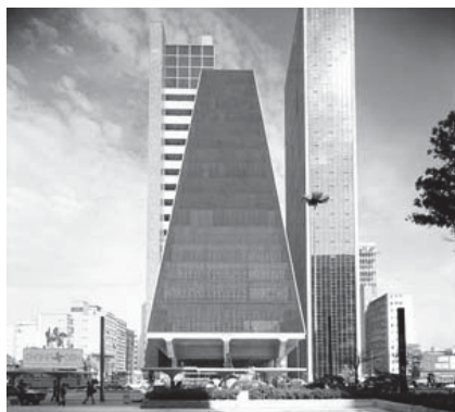
Figura 13 - Edifício Sede da Fiesp, São Paulo, 1969. Arquitetos: Roberto Cerqueira César e Luís Roberto Carvalho Franco
