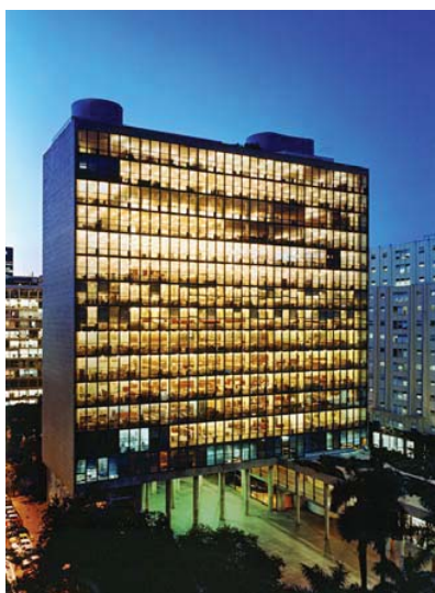
Figura 7 - Edifício do Ministério da Educação e Saúde, Rio de Janeiro, 1943 . Arquiteto: Lúcio Costa
