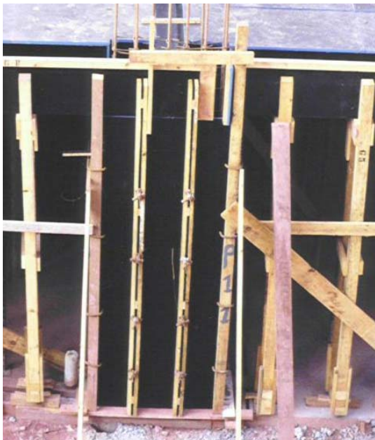
Figura 1.4c - Exemplo de Molde e Estrutura do molde de Pilar (*).
