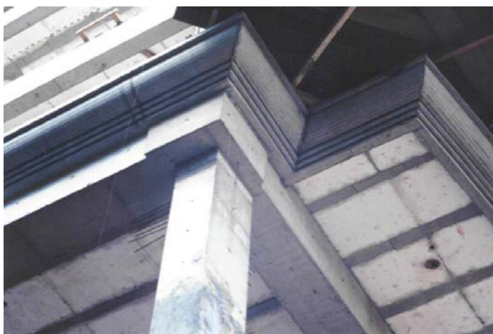
Figura 1.2 - Acabamento obtido utilizando fôrmas para concreto.
