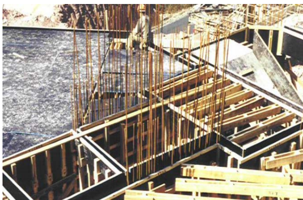
Figura 1.4a - Exemplo de Molde e Estrutura do molde de Laje-Viga (*).
