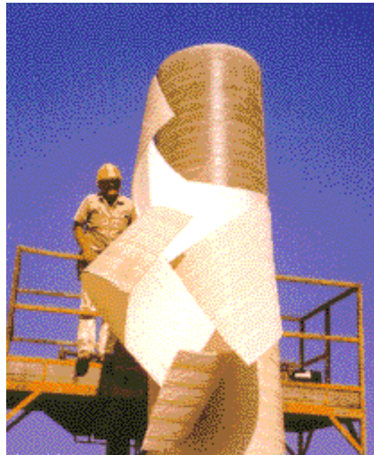
Figura 3.2.6.2.4 - Desfôrma da coluna (Fonte: Rib loc).
