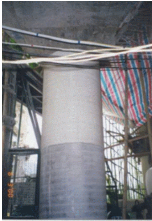
Figura 3.2.6.2.5 - Detalhe da coluna após a desfôrma (Fonte: Hundyai).
