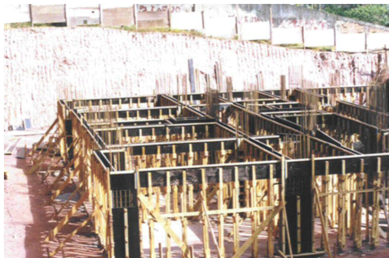
Figura 3.1.2 - Sistema de fôrma industrializado, onde se observa a uniformidade e padronização do Sistema de Fôrmas. (Fonte: Mauro Satoshi Morikawa).
