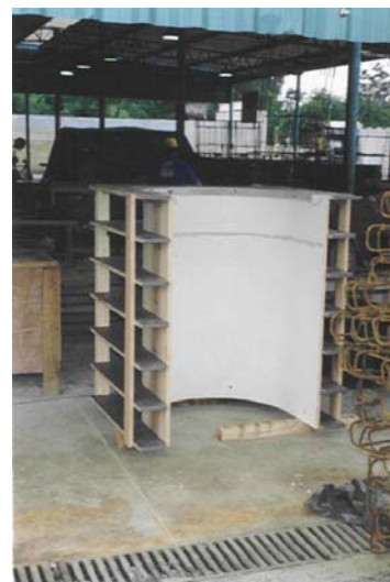
Figura 2.3.1.2 - Detalhe de fôrma utilizando chapa de PVC. Protótipo de cabine de fiscalização de ônibus - CEDEC/EMURB, SP. (Fonte: Mauro Satoshi Morikawa).
