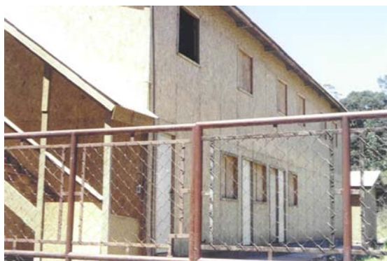
Figura 3.2.4.2 - Barracão de obra. Obra: Construtora. Shain, SP. (Fonte: Mauro Satoshi Morikawa).
