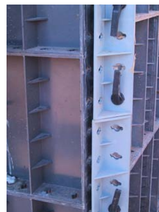
Figura 2.3.5.5 - Detalhe da placa, cantoneira e chaveta para fixação (Fonte: Betonform).
