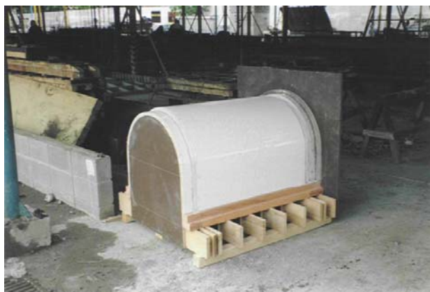
Figura 2.3.1.2 - Detalhe de fôrma utilizando chapa de PVC. Protótipo de cabine de fiscalização de ônibus - CEDEC/EMURB, SP. (Fonte: Mauro Satoshi Morikawa).
