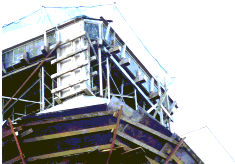
Figura 3.1.1 - Fôrma realizada pelo pessoal de obra, onde se observa a aleatoriedade dos componentes, sem critérios definidos. (Fonte: Mauro Satoshi Morikawa).
