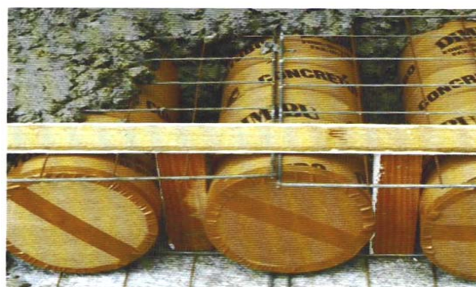
Figura 2.5.2 - Detalhe do concretubo para caixão perdido (Fonte: Dimibu).
