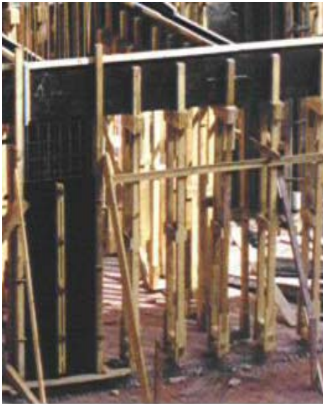
Figura 1.4b - Exemplo de Molde e Estrutura do molde de Viga (*).
