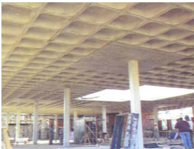
Figura 2.3.2.1 - Detalhe de laje nervurada finalizada, utilizando cumbucas de plásticos. (Fonte: Atex Brasil).
