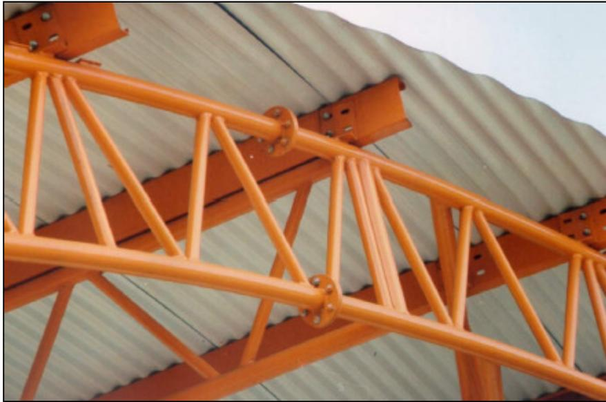
FIGURA3.19 Detalhe da ligação flange
