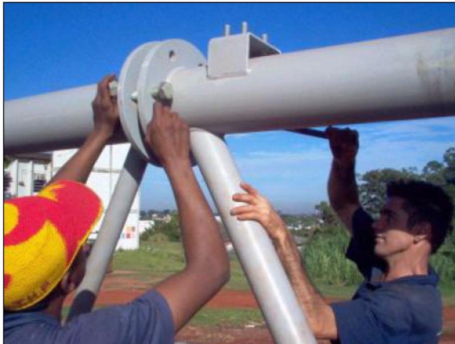
FIGURA3.22 Execução da ligação flange, Unicamp, Campinas-SP
