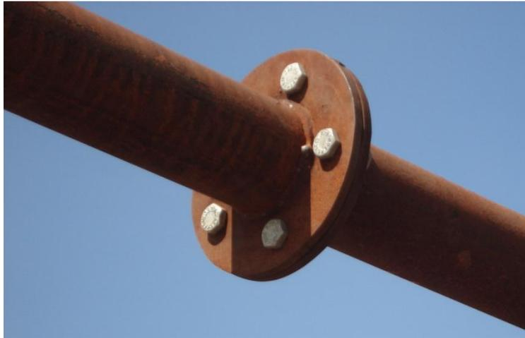
Figura 1.15 - Emendas de perfis tubulares com flange
