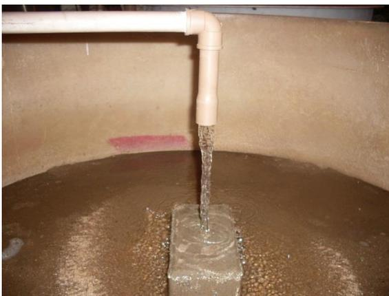
Figura 11:Placa de distribuição do líquido sobre a superfície dos filtros de areia
