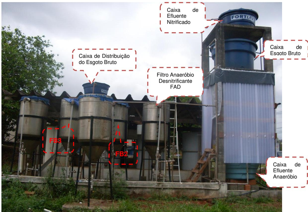
Figura 7: Vista das caixas de esgoto bruto, de distribuição do esgoto bruto, efluente anaeróbio e efluente nitrificado e dos filtros anaeróbios (FAD, FB2 e FB3).
