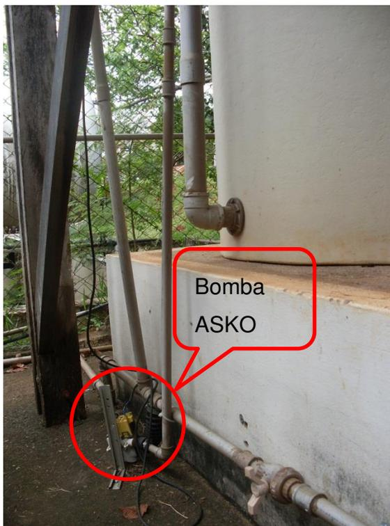
Figura 10. Detalhe da bomba de aplicação do efluente anaeróbio na superfície do filtro de areia
