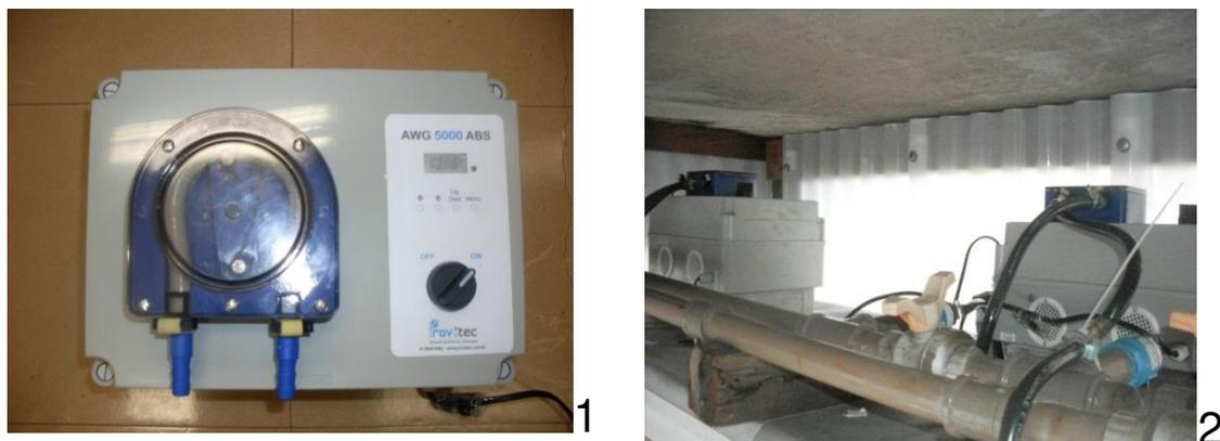
Figura 15:1 - Vista da superior da bomba peristáltica da marca Provitec e 2 – bombas peristálticas instaladas
