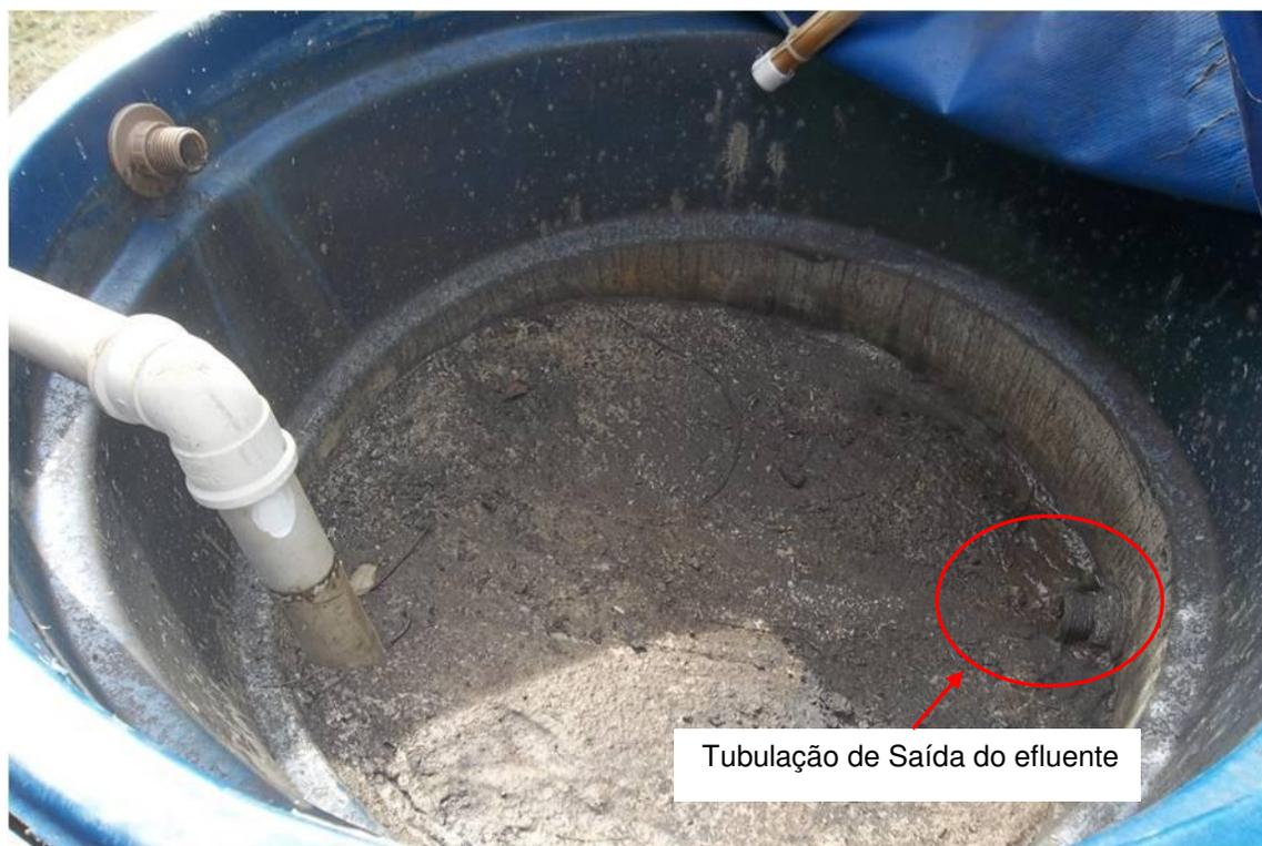
Figura 11: Caixa de distribuição do efluente anaeróbio, evidenciando a saída do efluente pela base da mesma.
