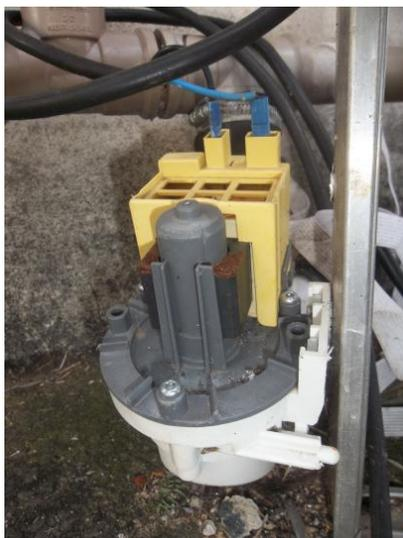
Figura 9: Bomba de recalque do efluente do filtro anaeróbio.
