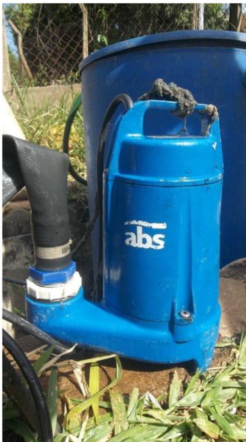
Figura 8: Bomba de captação do esgoto bruto.
