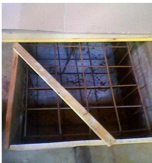
**Figura B02.** Construção da base de concreto para a bomba de alta pressão.
