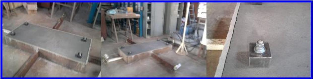
**Figura B03.** Instalação dos chumbadores e concretagem final.
