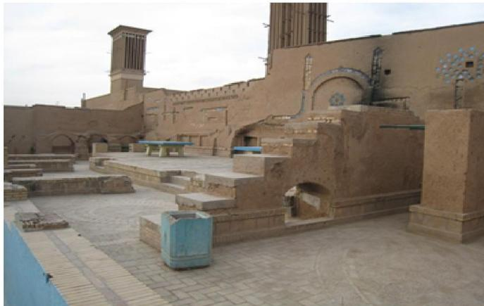
**Figura 2.10: Edificação no Iraque com torre de vento e pátio externo**
