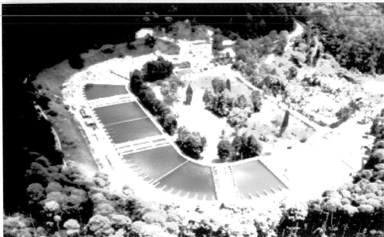
FIG. 37: ETA Morro Grande – Sistema Alto Cotia. FONTE: SABESP, 2002.
