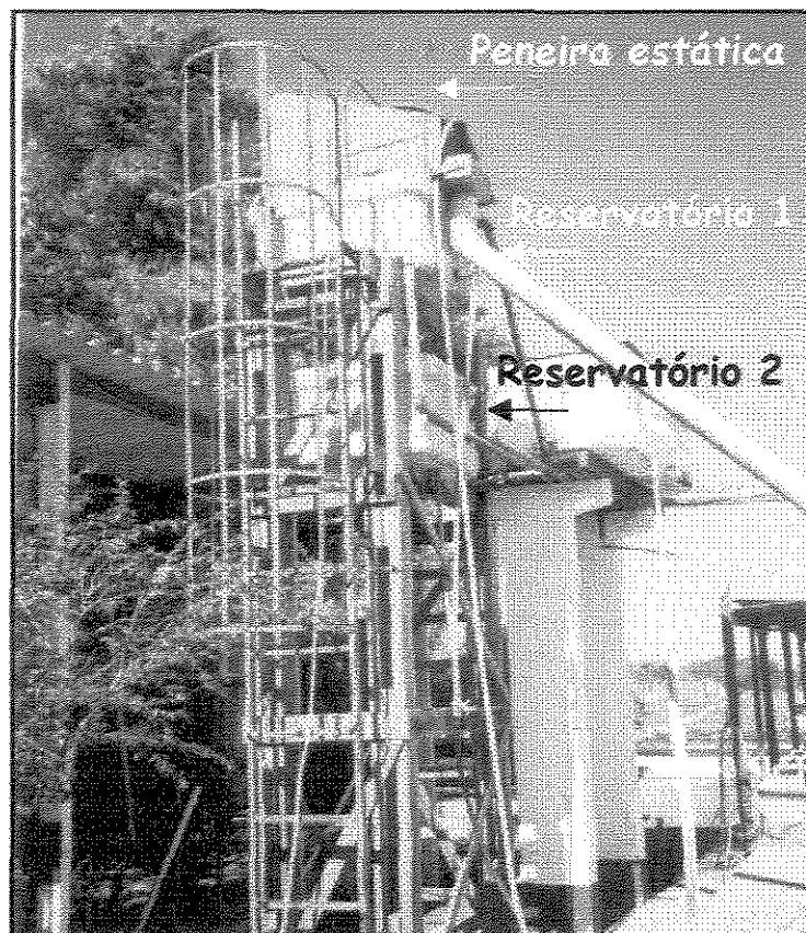
Figura 4.4: Sistema de alimentação do reator compartimentado anaeróbio/aeróbio
