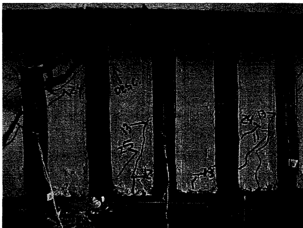
FIGURA 8.18 Detalhe da ruptura e do descolamento da fibra na Viga V4.
