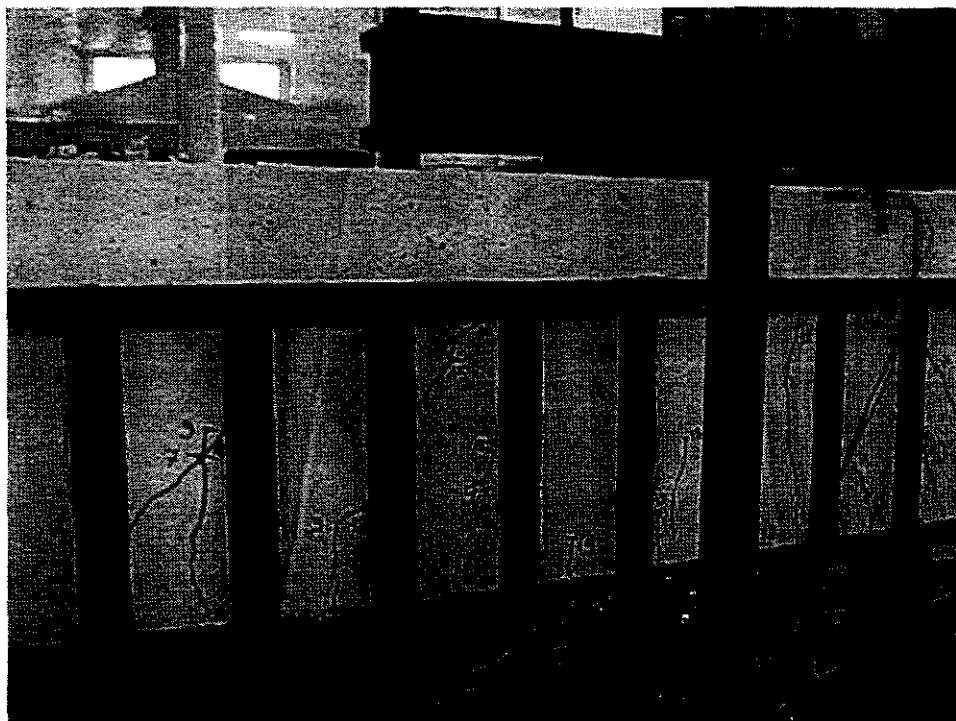
FIGURA 8.11 Panorama de fissuração Viga V2.
