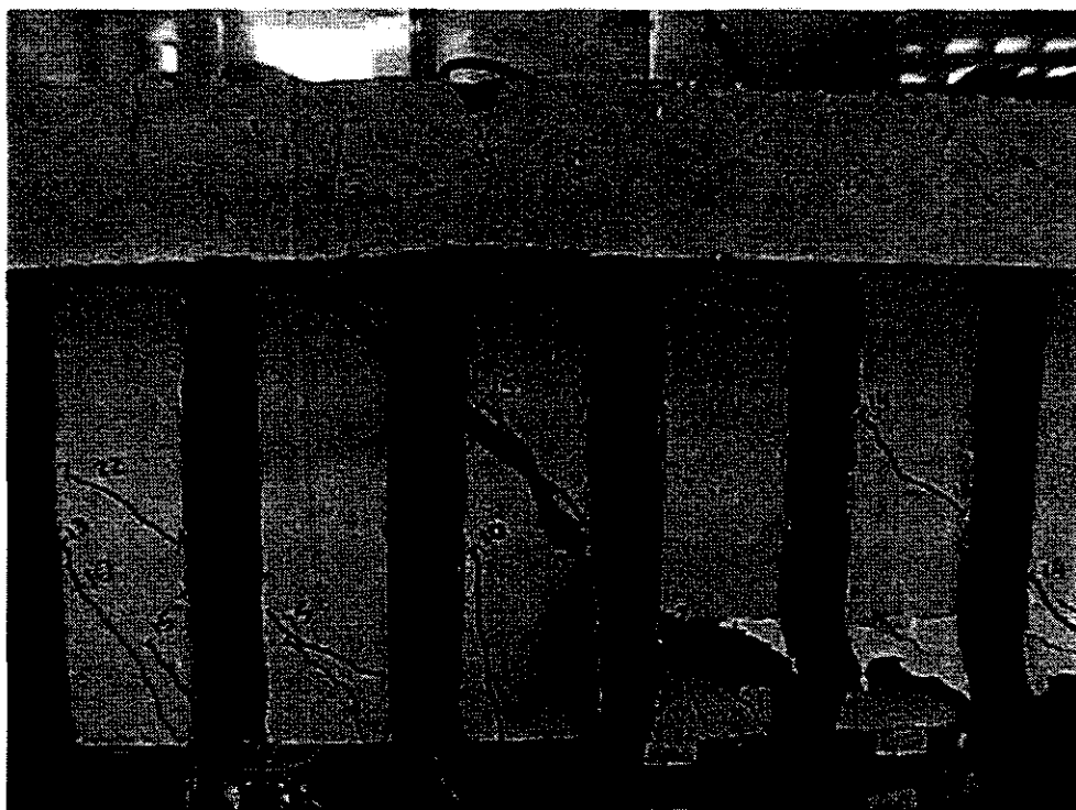
FIGURA 8.14 Panorama de fissuração da Viga V3.
