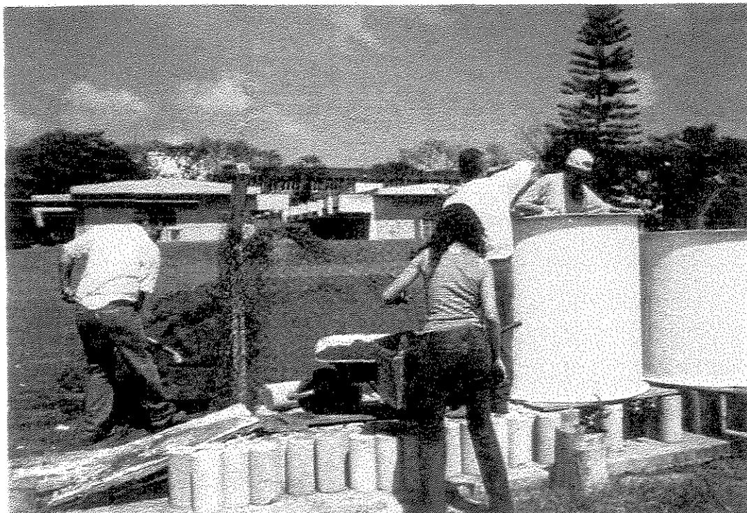
FIGURA 4.9 – Enchimento dos reatores com solo
