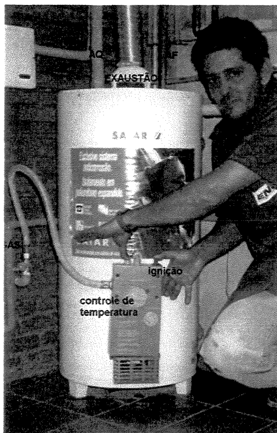
Figura 77 – Aquecedor de Acumulação a Gás Combustível de 85 litros Acionamento da partida (primeira ignição)
