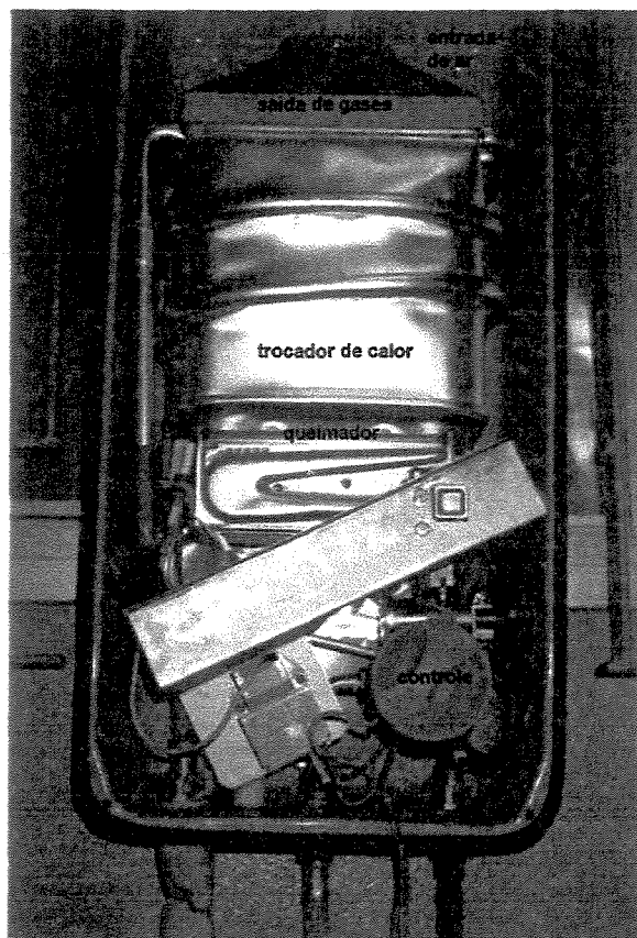
Figura 82 – Sistema Interno do Aq. de 6 litros “FB”de GLP
