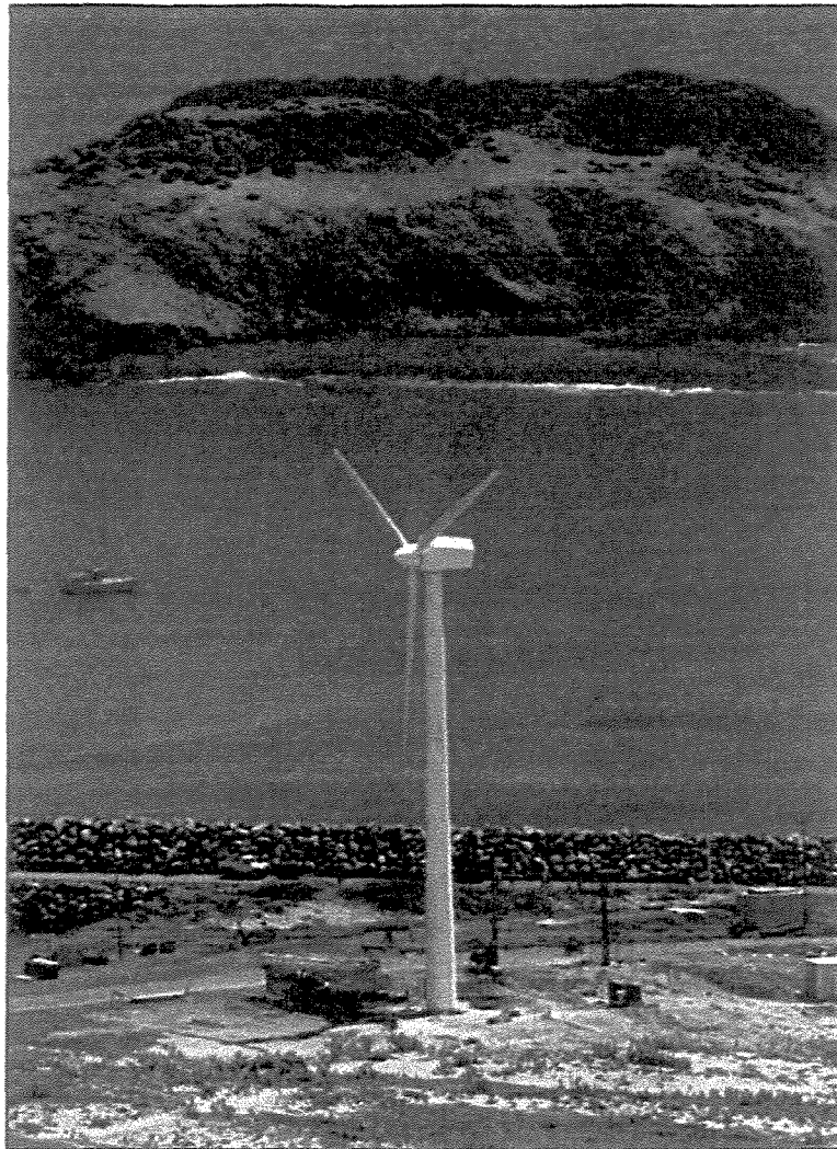
Figura 18 – Central de energia eólica – Fernando de Noronha
