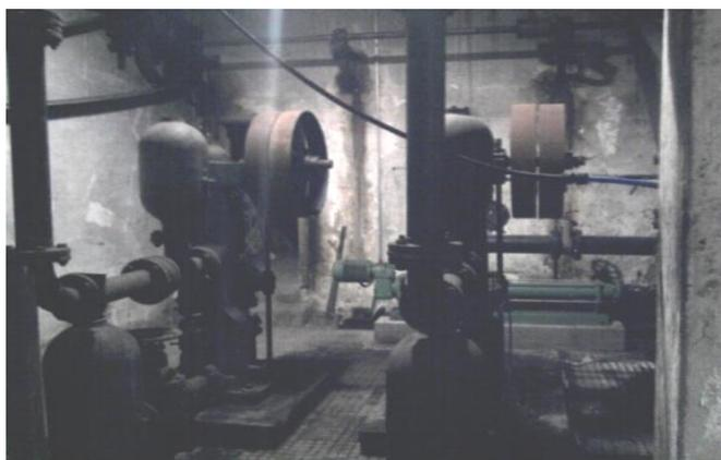
Figura 12: Sistema de bombeamentos por pistões
