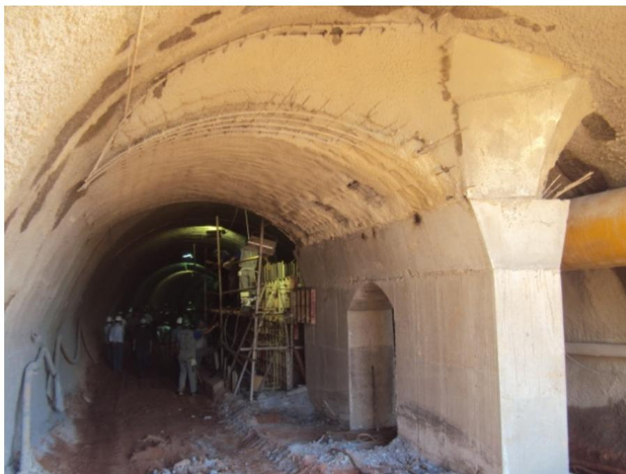
*Figura 9.13 - Concretagem finalizada túnel piloto 1 - arquivos Mendes Júnior*
