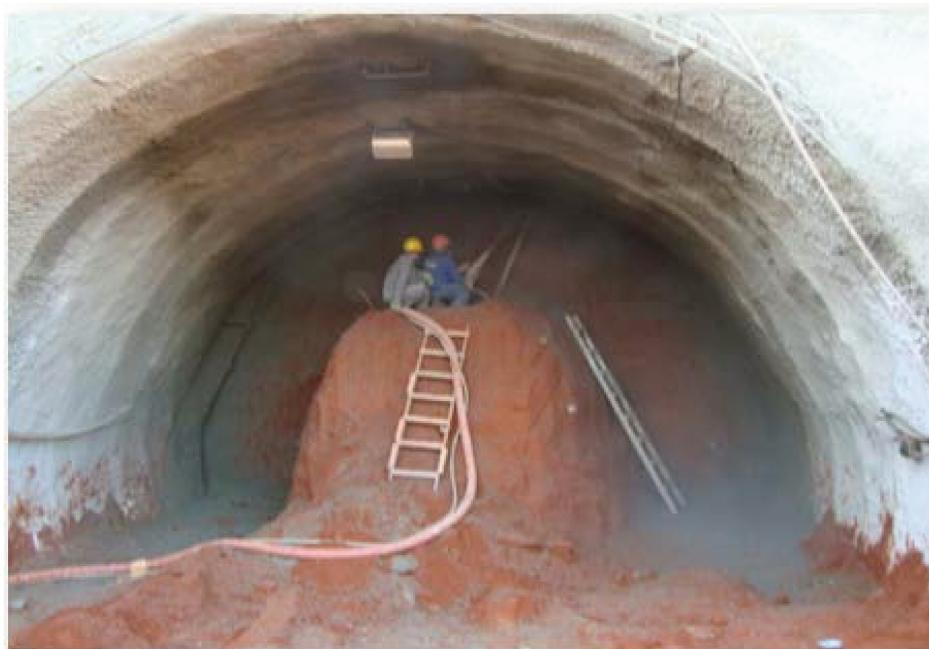
*Figura 8.1 - Aplicação concreto projetado - arquivos Mendes Júnior*
