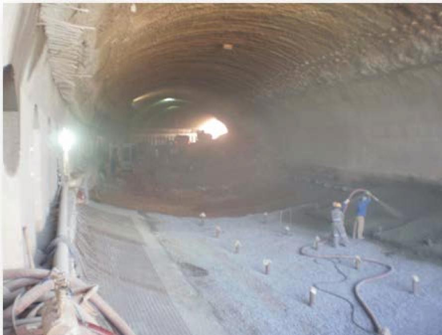
*Figura 8.15 - Execução concreto projetado no invert - arquivos Mendes Júnior*
