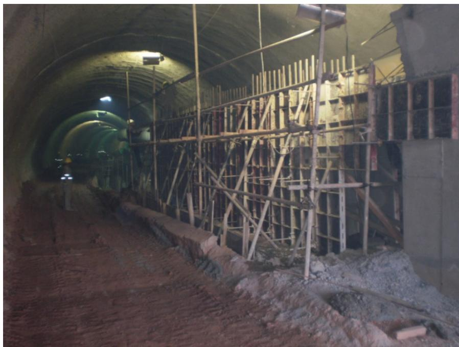
*Figura 9.7 - Execução da forma do pilar sobre a viga de fundação túnel piloto 1 - arquivos Mendes Júnior*
