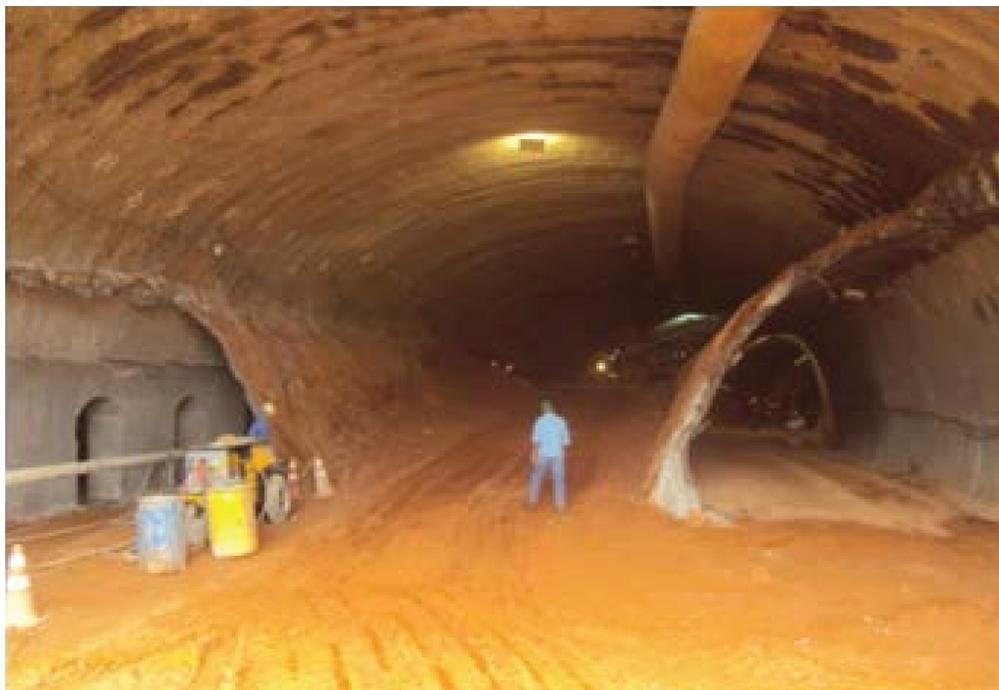
*Figura 7.2 - Paredes dos túneis pilotos 1 e 2 - arquivos Mendes Júnior*
