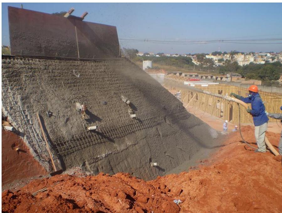
*Figura 6.5 - Aplicação do concreto projetado no talude - arquivos Mendes Júnior*
