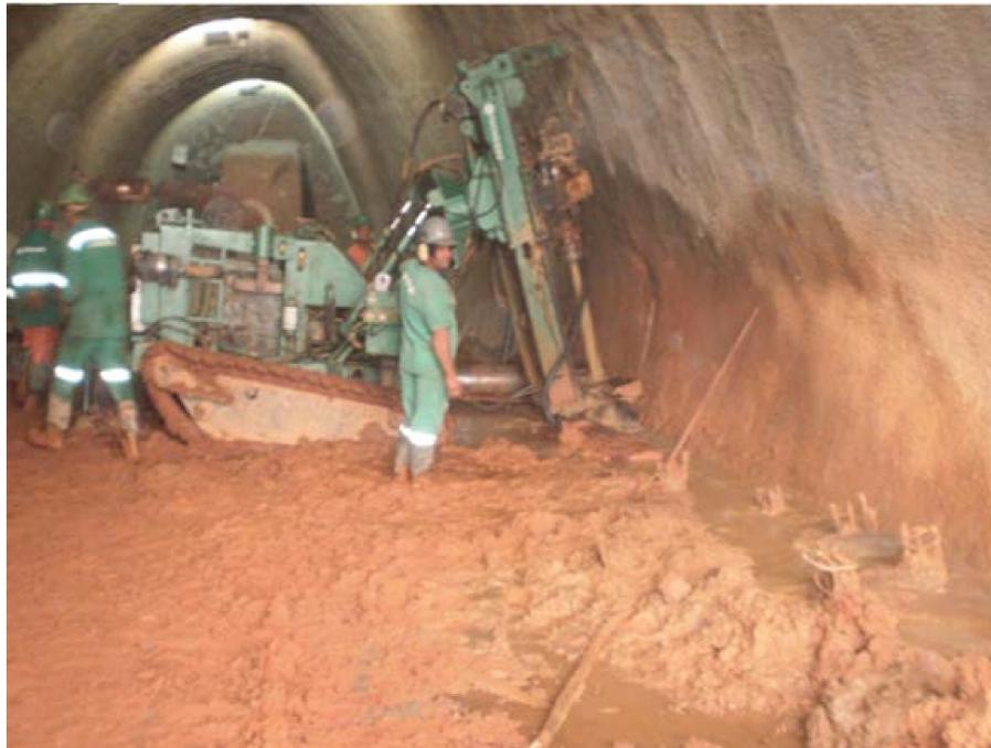
*Figura 9.4 - Execução estaca raiz dentro do túnel piloto 1 - arquivos Mendes Júnior*
