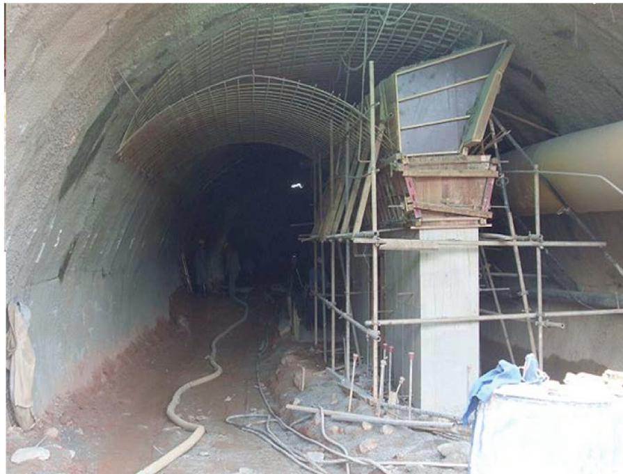
Figura 9.11 - Detalhe da armação túnel piloto 1 - arquivos Mendes Júnior
