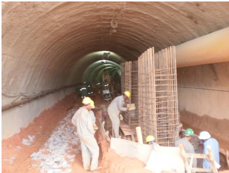
*Figura 9. 6 - Execução da armação do pilar sobre a viga de fundação túnel piloto 1 - arquivos Mendes Júnior*
