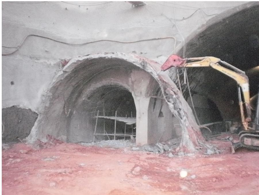
*Figura 9.15 - Demolição da estrutura provisória túnel piloto 1 - arquivos Mendes Júnior*
