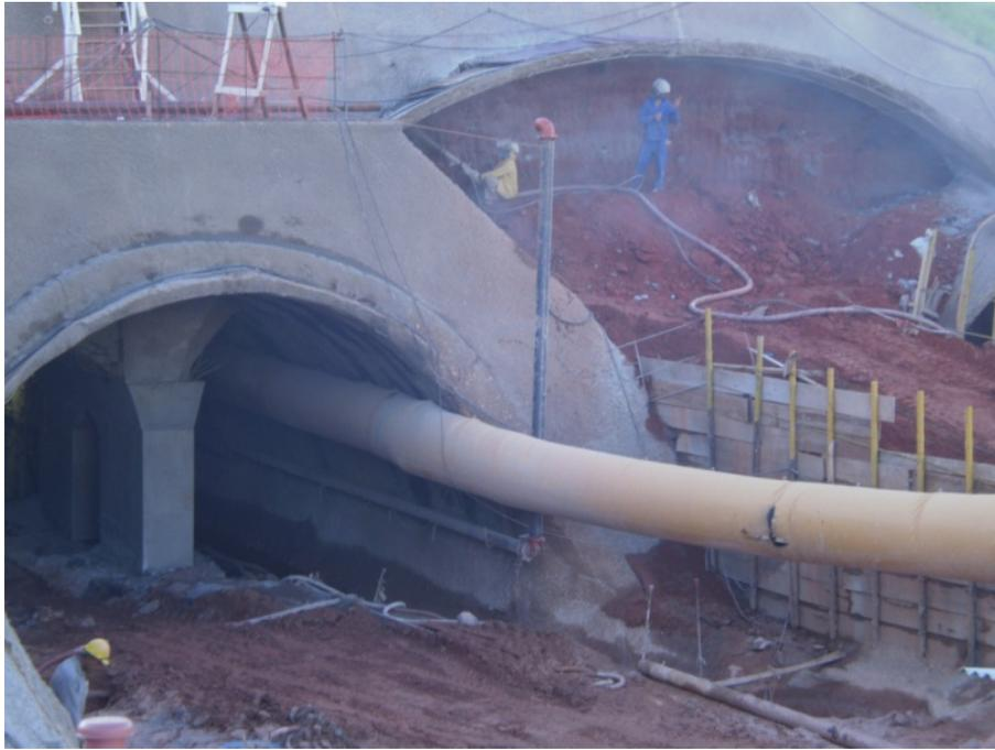
Figura 9.8 - Estrutura Completa (viga de fundação, pilar e preenchimento) - túnel piloto 1
