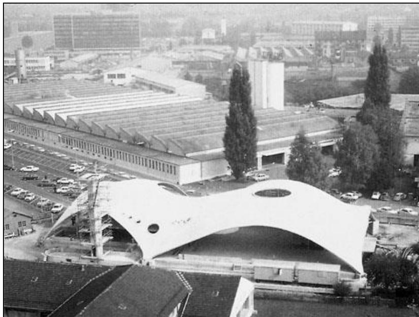
Figura 2.10: *Sicli Company Building*. Estrutura em casca de forma livre projetada por Heinz Isler.
