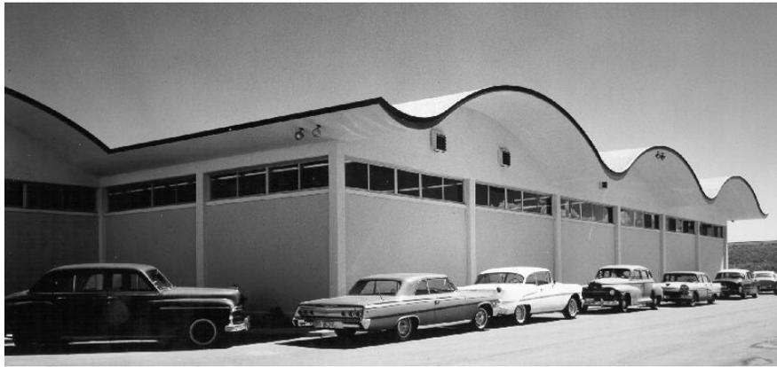
Figura 2.16: Cobertura em casca cilíndrica múltipla<sup>12</sup>.
