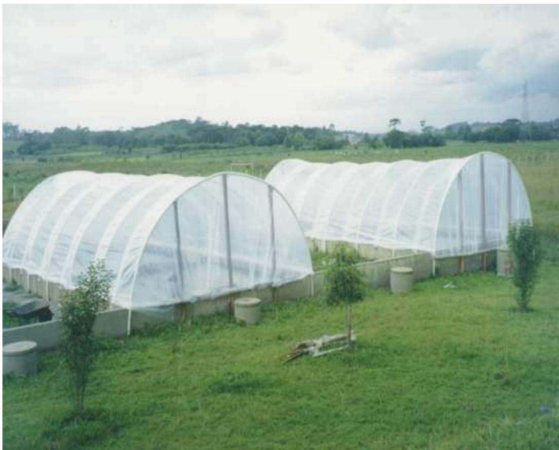
Figura 3.8 – Leito de secagem drenante com cobertura vinílica translúcida proposto para desidratação do lodo
