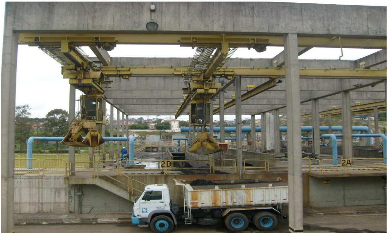
Figura 2.5 – Sistema de remoção de areia das caixas de retenção da ETE-Barueri
