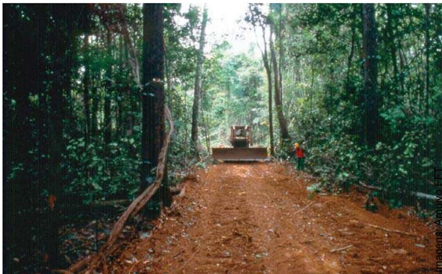
**Figura 2.24: Redução da largura de estradas florestais com uso de equipamento apropriado**
