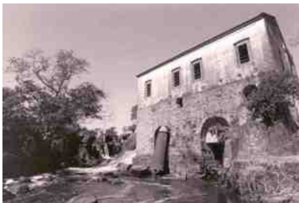
Figura 20. UHE Luís de Queirós em Piracicaba. A casa da bomba elevatória. A hidrelétrica devia ser uma edificação idêntica já que fazem parte de um conjunto, abastecido pelo mesmo canal adutor. Fonte: www.semaepiracicaba.org.br
