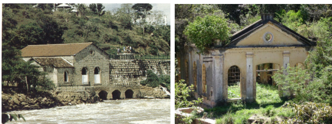
Figura 123. Fig. 123A. UHE Salto, Salto. Fig.123B. Ruínas da UHE Quilombo; Jundiaí. Fonte: Fundação Energia e Saneamento (2010).
