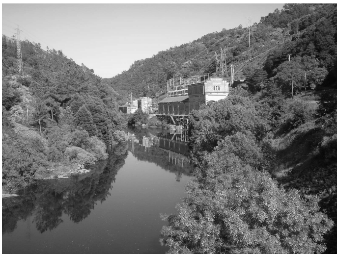
Figura 69. Central hidrelétrica do Lindoso. Portugal. Foto do autor, 2009
