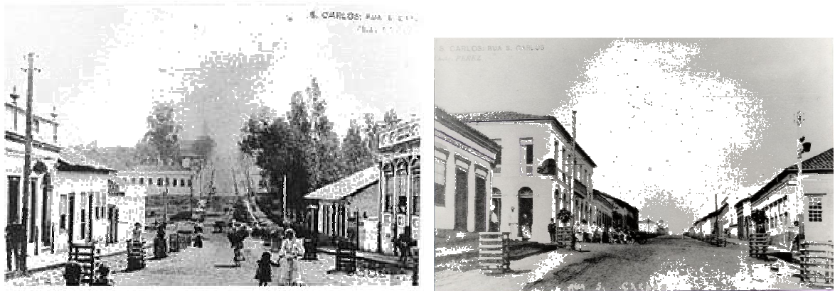
Figura 26. Fig. 26A. Av. São Carlos em 1888/89. Fig. 26B. Av. São Carlos em 1910. Fonte: Arquivo Municipal/Fund. Pró-Memória de São Carlos
