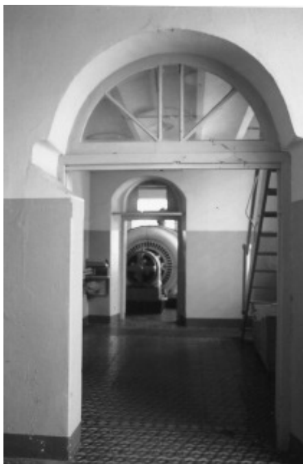
Figura 80. Sala de máquinas da UHE Capão Preto, São Carlos, SP. Foto da autora, 2002
