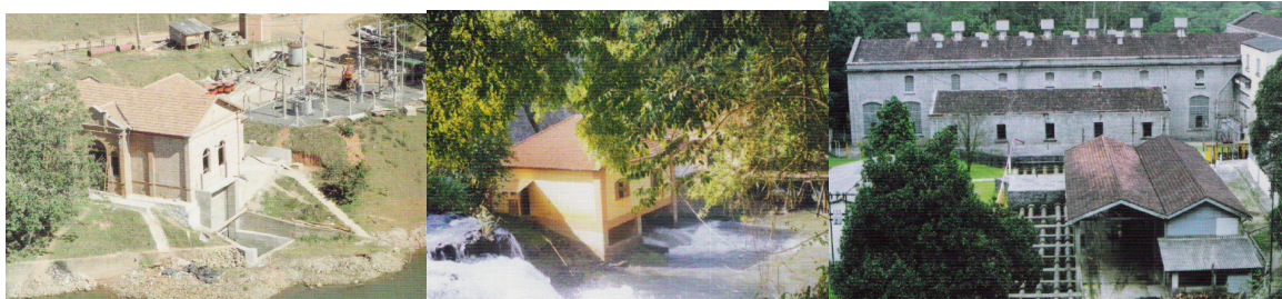
Figura 63. Fig. 63A. UHE Socorro, Socorro Fig. 63B. UHE Rio Novo, Avaré Fig. 63C. UHE Itatinga, Bertioiga. Fonte: AMARAL e PRADO (2000)
