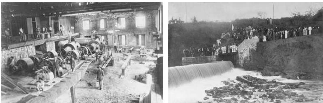
Figura 53. Fig. 53A. Reforma da casa de máquinas, 1899. Acervo: Arquivo Municipal de Rio Claro. Fig. 53B. Reinauguração da Usina, 1900. Fonte: Exposição - Contando a História de uma Usina. Disponível em
