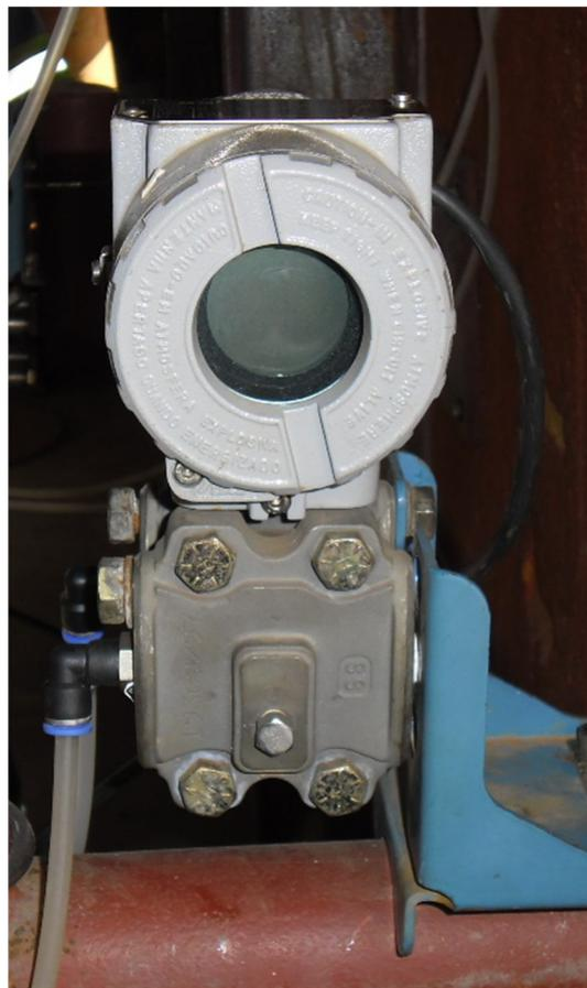
Figura 4.13 - Transmissor de pressão a montante da ventosa (SMAR)
