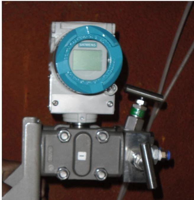
Figura 4.11 - Transmissor de pressão diferencial (Siemens)
