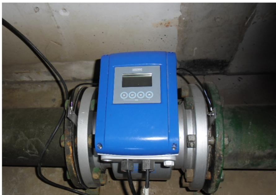
Figura 5.3 - Medidor de vazão
