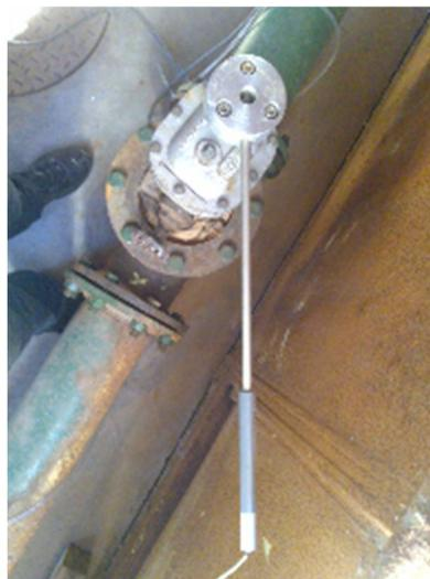
Figura 4.3 - Esquema do detalhe da fixação do anemômetro à ventosa
