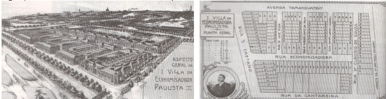
Figura 7 - Vila particular Economisadora, de 1907, localizada em São Paulo. Para os padrões da época foi um grande empreendimento rentista (que visava o lucro da iniciativa privada através da renda do aluguel). Podemos observar a subdivisão dos quarteirões em lotes, baseados na casa unifamiliar.
