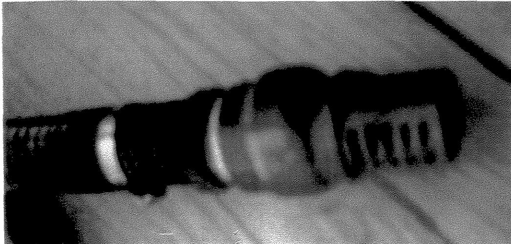
Foto 6.2. Válvula de pé e crivo, na tubulação de sucção da instalação.
