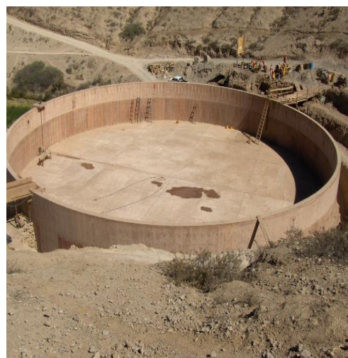
Figura 5.2: Parede do reservatório
