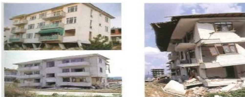
Figura 2.13: Pavimento flexível ou soft-storev (LESTUZZI, 2008)
