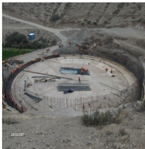
Figura 5.3: Laje fundo do reservatório
