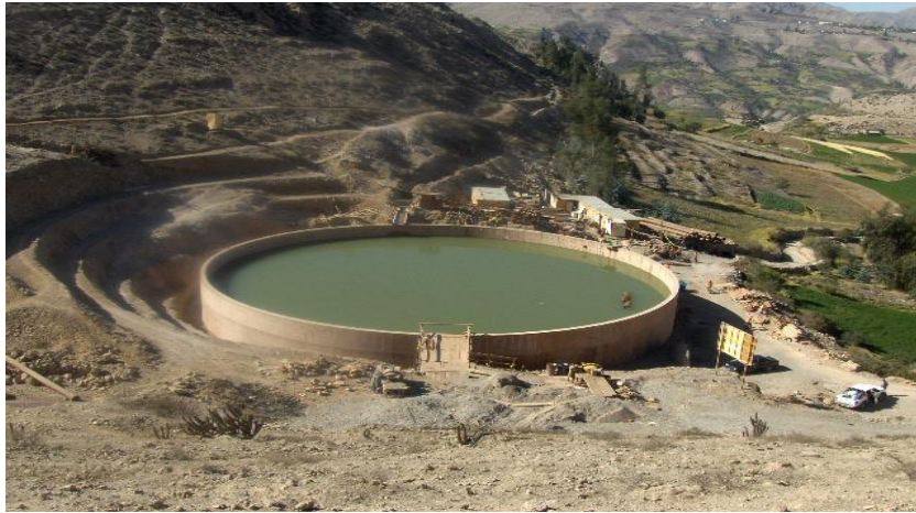
Figura 5.4: Reservatório cheio de água
