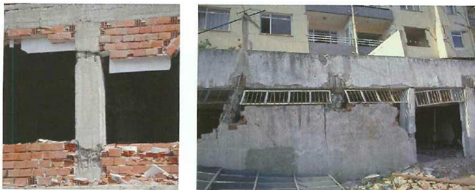
Figura 2.14: Pilares com deformações laterais impedidas numa parte de sua altura (LESTUZZI, 2008)
