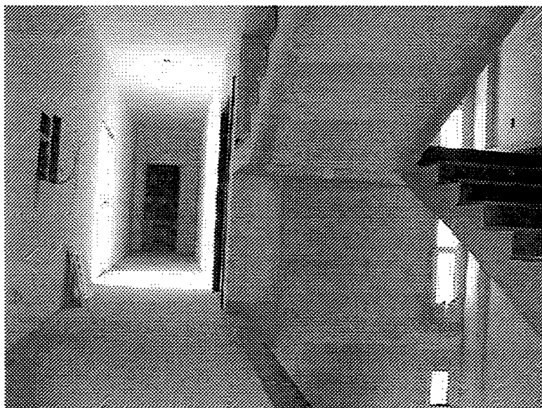
Figura 9- Observar iluminação lateral caixa de escada e iluminação do hall
