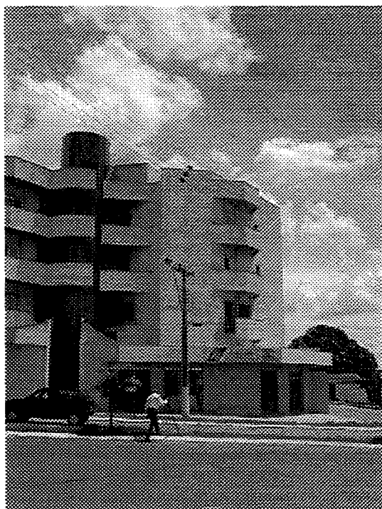
Figura 6- Vista do bloco2 –observar sombreamento proporcionado pelo deslocamento dos volumes
