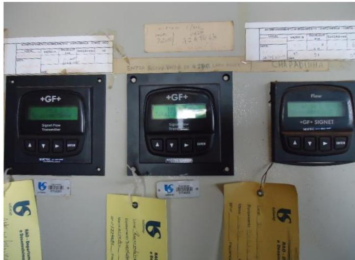
**Figura 13 - Elementos secundários do medidor eletromagnético dos Setores Chapadinha/ Zona Baixa, Jardim Atenas do Sul e do sistema reserva (foto do autor).**
