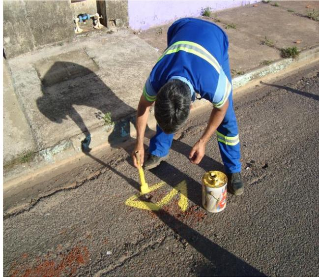
**Figura 25 - Marcação do local do vazamento no Setor de Abastecimento Jardim Atenas do Sul (foto do autor).**
