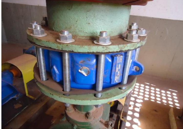
**Figura 15 - Válvula de Retenção da Estação Elevatória de Água Tratada do Setor Jardim Atenas do Sul (foto do autor).**
