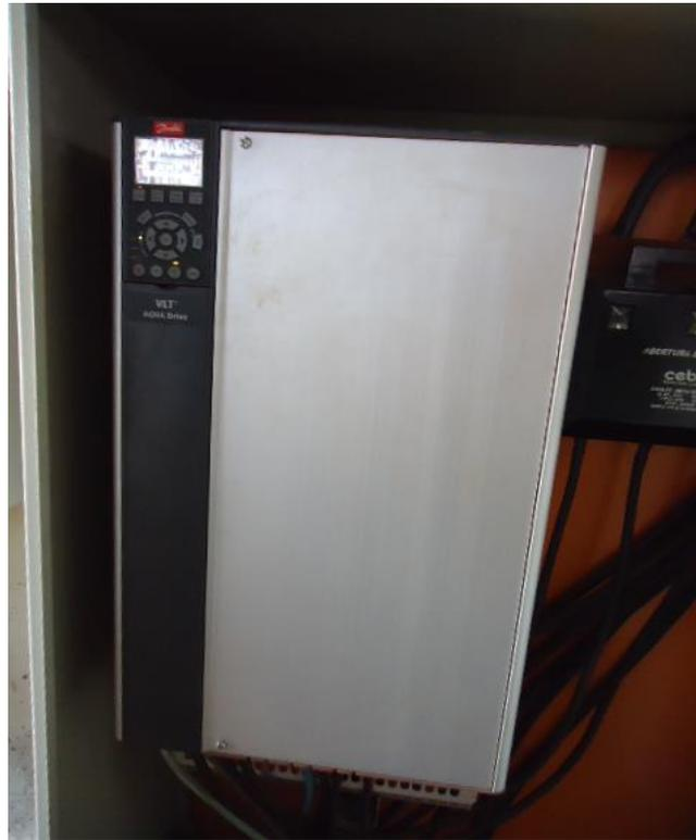
**Figura 17 - Inversor de Frequência do Setor Jardim Atenas do Sul (foto do autor).**
