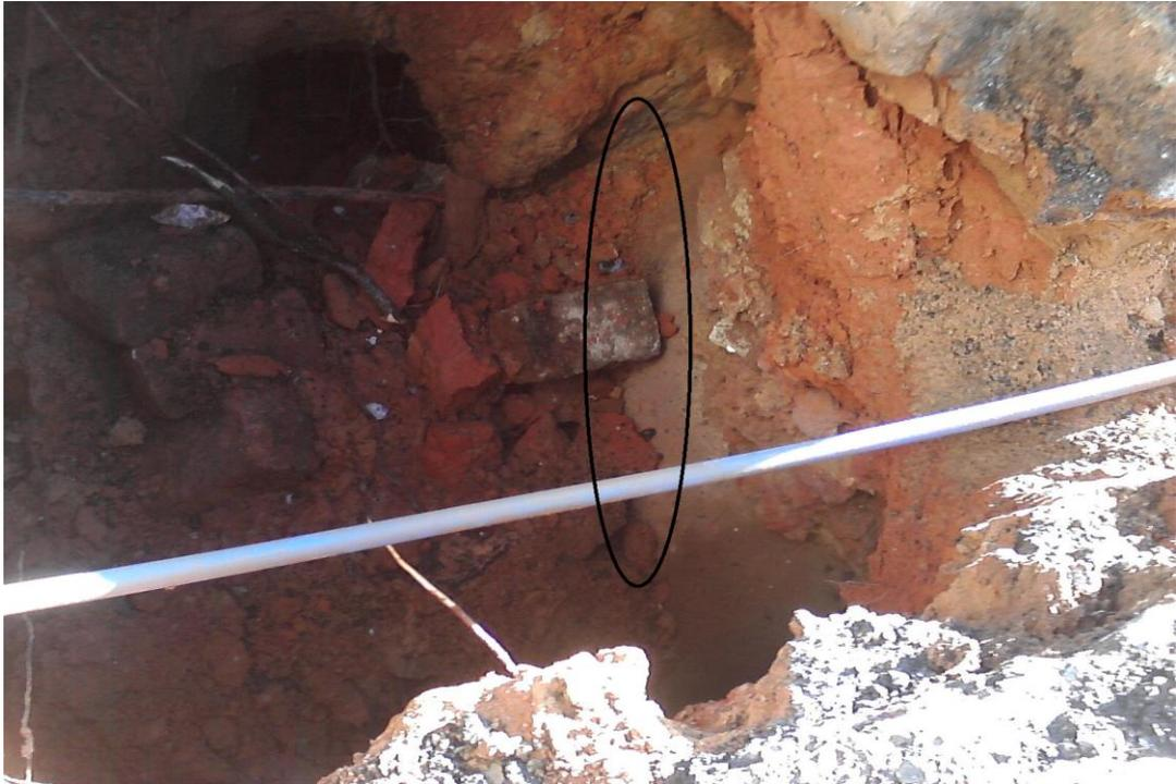
**Figura 3 - Exemplo de vazamento em adutora rompida de difícil detecção devido ao escoamento da água proveniente de perdas reais em galeria de águas pluviais (foto do autor).**
