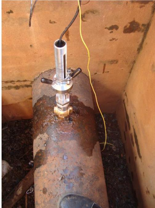
**Figura 23 - Medidor Eletro Magnético de Inserção instalado em adutora de 300 mm na saída da Estação Elevatória de Água Tratada Nastri (foto do autor).**
