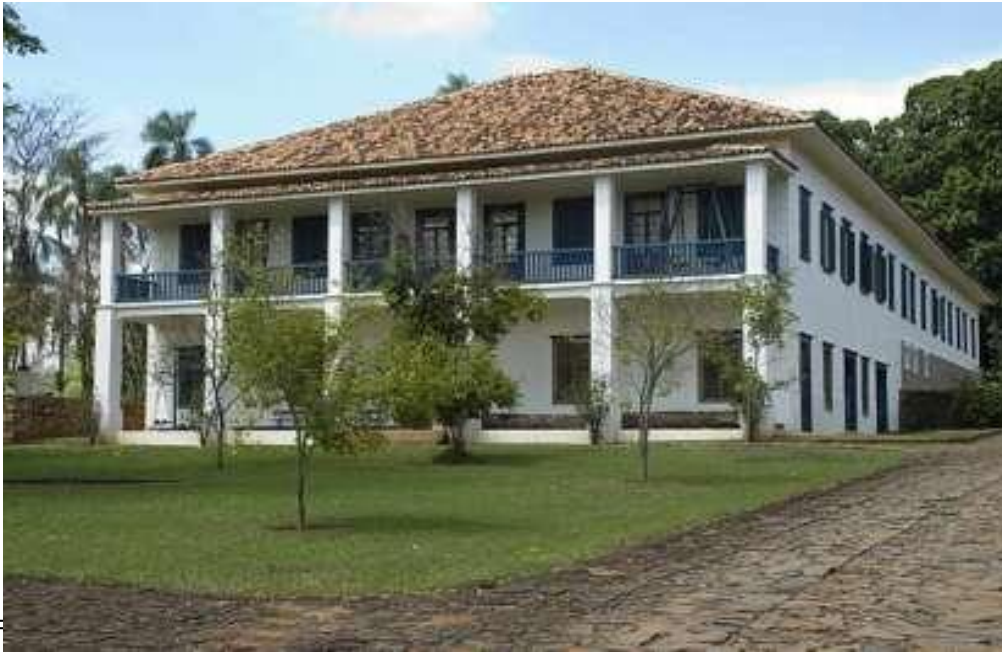
Figura 12 - Fachada modificada da casa sede.
