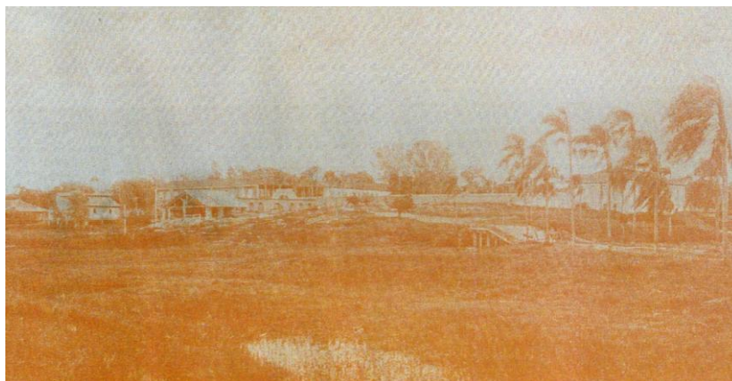
Figura 41 - Vista geral da fazenda da Barra e ponte sobre o rio Camanducaia.
