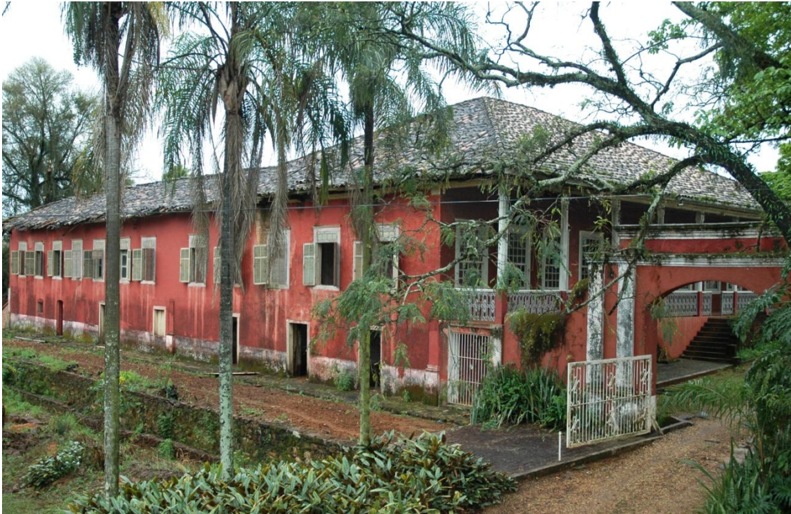
Figura 88 - Fachada lateral esquerda.
