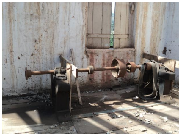
Figura 82 - Tulha, vista interna com carcaça de maquinário.
