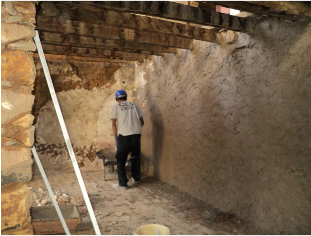
Figura 91 - Porão com parte do pilar em alvenaria de pedra aparente.
