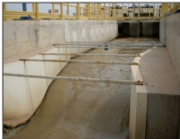
**Figura 4.40** - Calha Parshall na entrada do efluente bruto.
