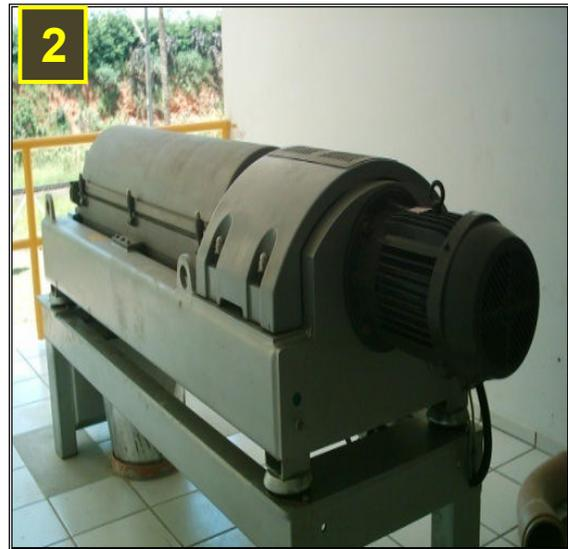
**Figura 5.4** – Casa de química (ponto 1) coleta do lodo após a centrífuga e centrífuga (ponto 2) ETE Camanducaia.
