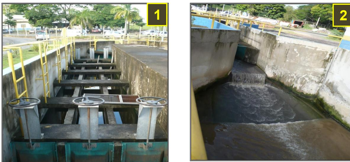
**Figura 5.2** - Chegada do efluente bruto (ponto 1) e local de coleta do esgoto bruto na ETE Camanducaia (ponto 2).
