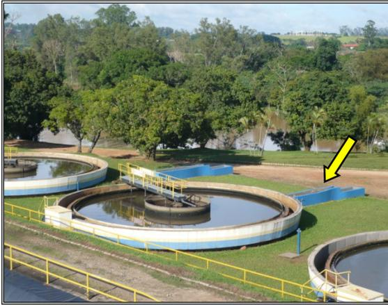
**Figura 4.33** - Calha Parshall na saída dos decantadores.
