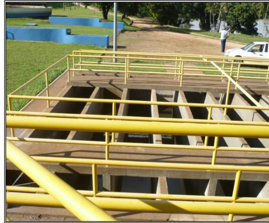
**Figura 4.34** - Tanque de contato.
