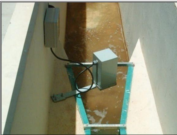
**Figura 4.28** - Medidor de Vazão.
