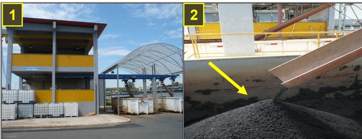
**Figura 5.8** – Centro de centrifugação do lodo (ponto 1) e lodo dispostos na caçamba após centrifigados (ponto 2) - ponto de coleta do lodo ETE Anhumas.
