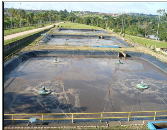
**Figura 4.29** - Visão geral dos tanques de aeração.
