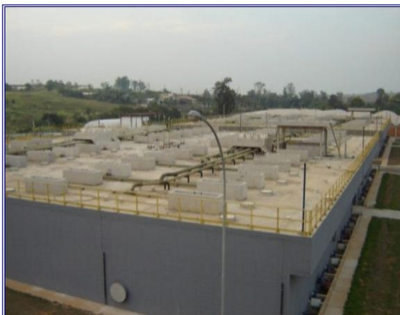
**Figura 4.42** - Reator anaeróbio de fluxo ascendente.
