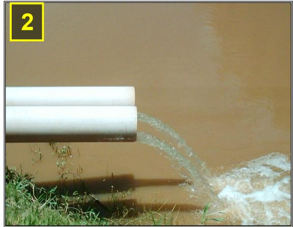
**Figura 5.3** – Calha Parshall do efluente tratado (ponto1) - Ponto de coleta do esgoto tratado na ETE Camanducaia e despejo do efluente tratado no rio Camanducaia (ponto 2).
