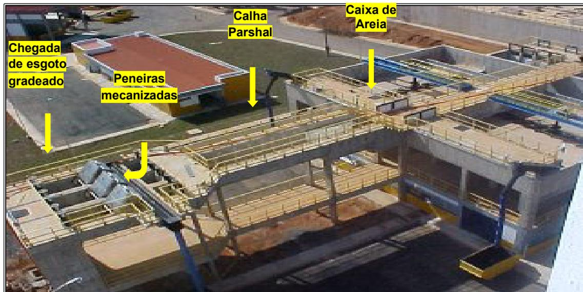
**Figura 4.38** - Visão geral do tratamento preliminar. Fonte SANASA.
