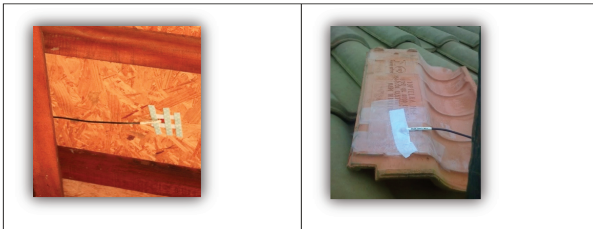
Figura 22 – Sensores para medição de temperatura superficial fixados sob a cobertura verde e uma telha cerâmica.
