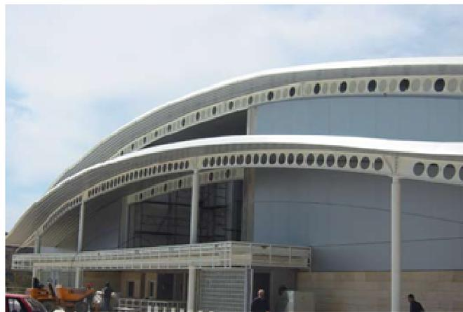
Figura 2.22 – Viga celular curva. Fonte: ARCELOR MITTAL (2010).
