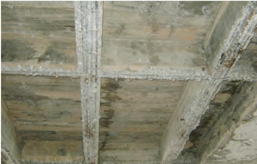
FIGURA 87: Obras de reforma do Palácio da Agricultura: estado de conservação das estruturas de concreto, 2009. Arquivo CPOS, Proc. n. 182/2008. Foto do autor. O estado de conservação dos elementos estruturais foram os principais fatores de atrasos na obra e retrabalho em relação ao cronograma previsto.
