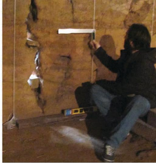
FIGURA 131: Proposta de documentação de parede da Tulha: constituição de eixos verticais y a distâncias de acordo com facilidade de medição arquitetônica direta, 2012. Foto Regina Tirello.
