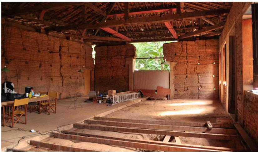
FIGURA 126: Tulha: interior, 2012. Foto do autor. Destaque para escavações visíveis para identificação de fundações.
