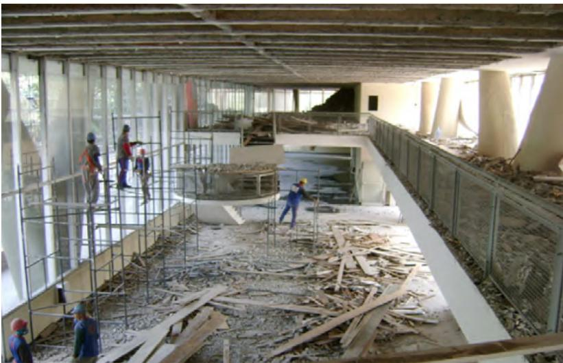
FIGURA 86: Obras de reforma do Palácio da Agricultura: remoção da mesa inferior e do caixão perdido, 2009. Arquivo CPOS, Proc. n. 182/2008. Foto do autor.
