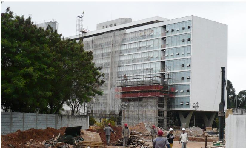
FIGURA 88: Obras de reforma do Palácio da Agricultura: construção da torre de escadas de segurança, 2010. Arquivo CPOS, Proc. n. 182/2009. Foto do autor. Devido às exigências finais do CONPRESP, foram revistas posicionadas na fachada posterior em respeito aos valores urbanos do conjunto.
