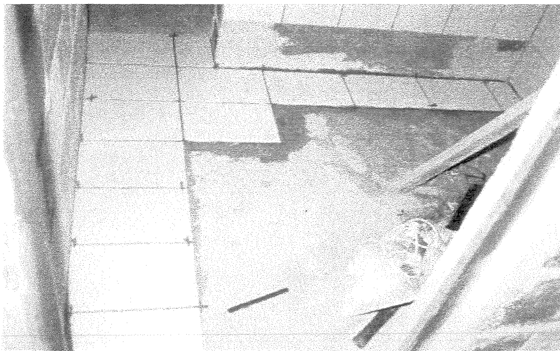
FIGURA C 8: Aulas de assentamento de azulejos – detalhe dos espaçadores FONTE: Sérgio B. Aranha, julho/2000
