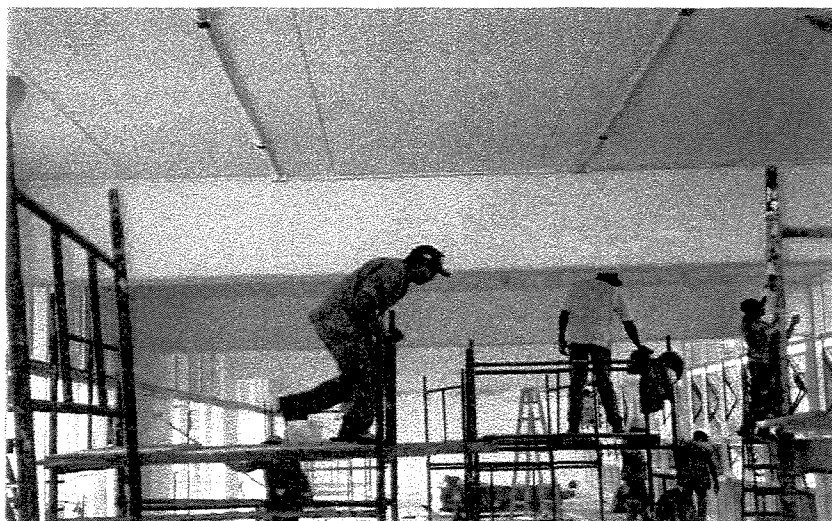
FIGURA E 5: Vista interna do edifício FONTE: Aparecido Fujimoto, 2001
