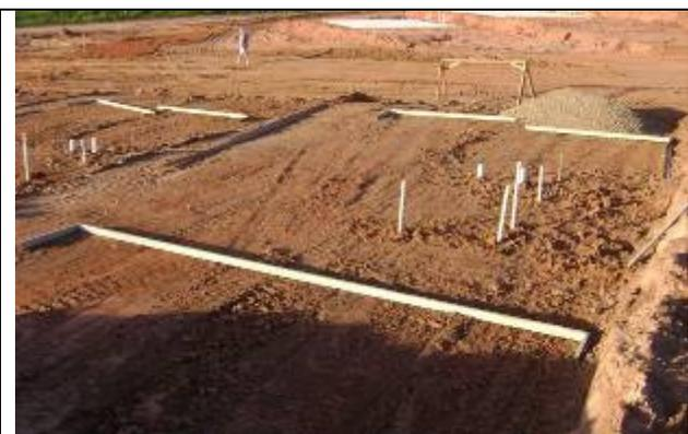
Figura 5.4 – Vista das fôrmas para execução do radier.
