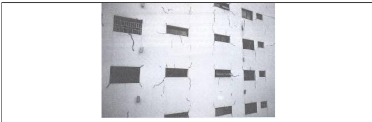
Figura 2.17 – Fissuras generalizadas causadas por retração de janelas (THOMAZ, 1989).
