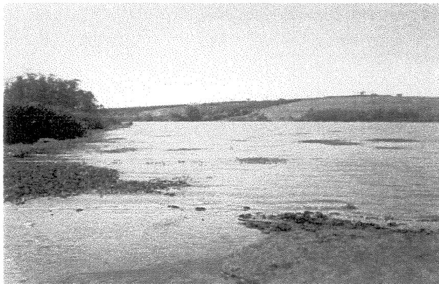
Fig. 5.56 – Aporte de sedimentos de BLJ no reservatório da represa - BLJ
