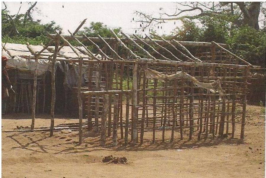
FIGURA 1b Construção de pau a pique. Estrutura de base retangular. África.
