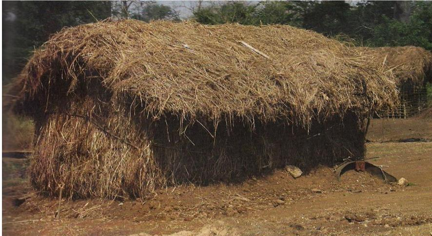
FIGURA 1a Palhoça construída com técnicas primitivas. (foi utilizado ramas de capim seco sobre galhos de madeira, com a cobertura em duas águas). Região de Caxito, situada 50 km ao norte de Luanda, Angola.
