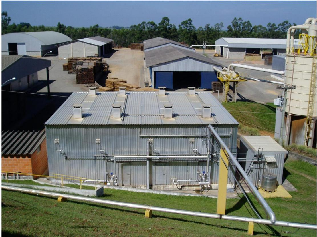
FIGURA 47 Secador convencional com capacidade para 150m<sup>3</sup>. Indusparquet, 2012.
