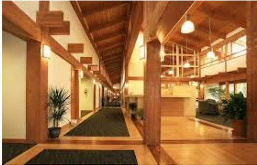
FIGURA 33 Pilares e Vigas de madeira usados em construção.
