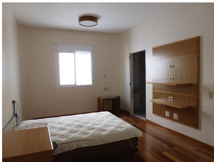
Figura 37: Estudo de caso 2: quarto e banheiro durante obra – carpete trocado por piso de madeira estruturada, transição entre piso de madeira e porcelanato em nível, sem degrau na soleira.
