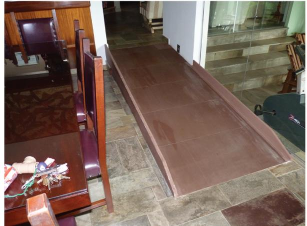
Figura 27: foto da rampa com 12% de inclinação.
